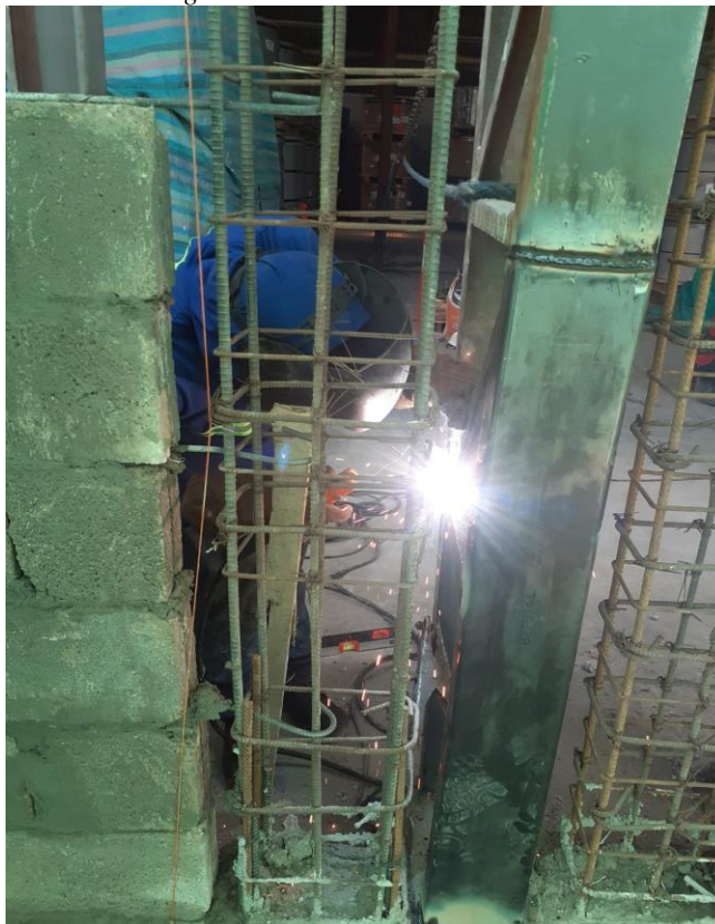
Figura 13 Soldadura de estructura
