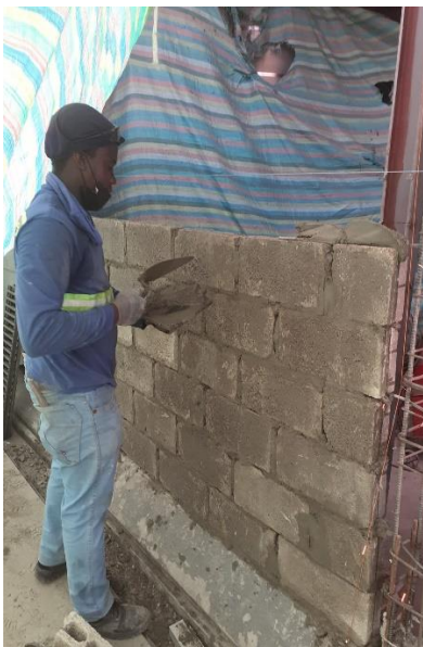
Figura 8 Levantamiento de muros
