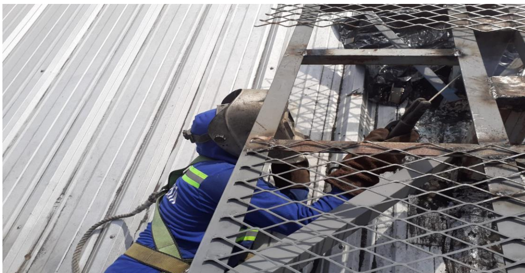
Figura 14 Soldadura de estructura en postura prolongada
