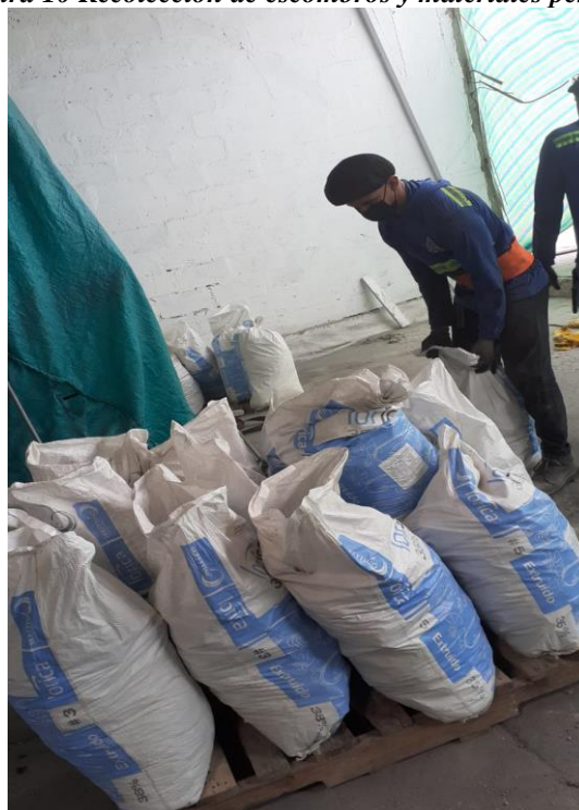
Figura 10 Recolección de escombros y materiales pesados
