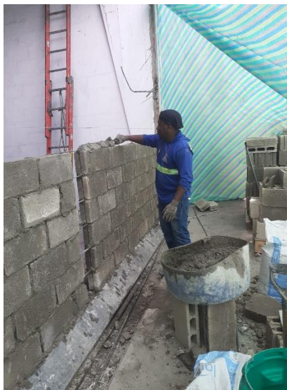
Figura 7 Pega de ladrillos
