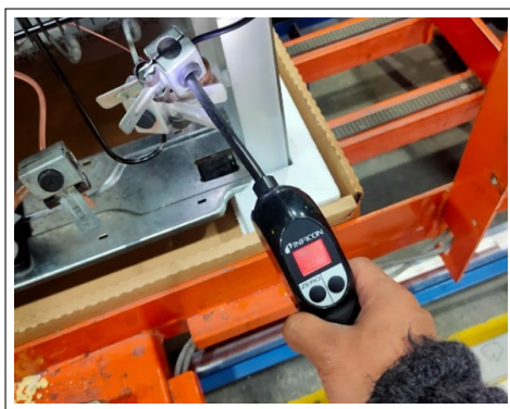
a) Prueba con detector de fugas.
