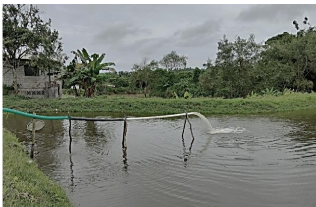
Figura 5.15 Bombeo de agua.
