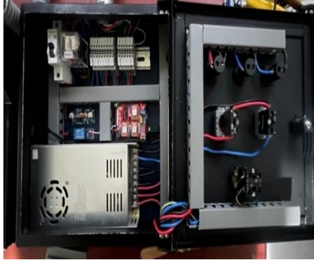
Figura 67 - Colocación de tapas en canaletas.
