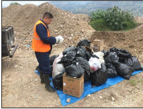
Ilustración 19. Homogenización y cuarteo de los residuos. Fuente: Elaboración propia.
