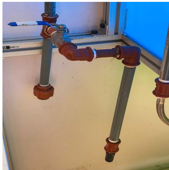
Figura 6.3: Instalación de la tubería para el flujo de agua
