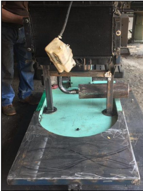
ANEXO 6: Construcción de la estructura
