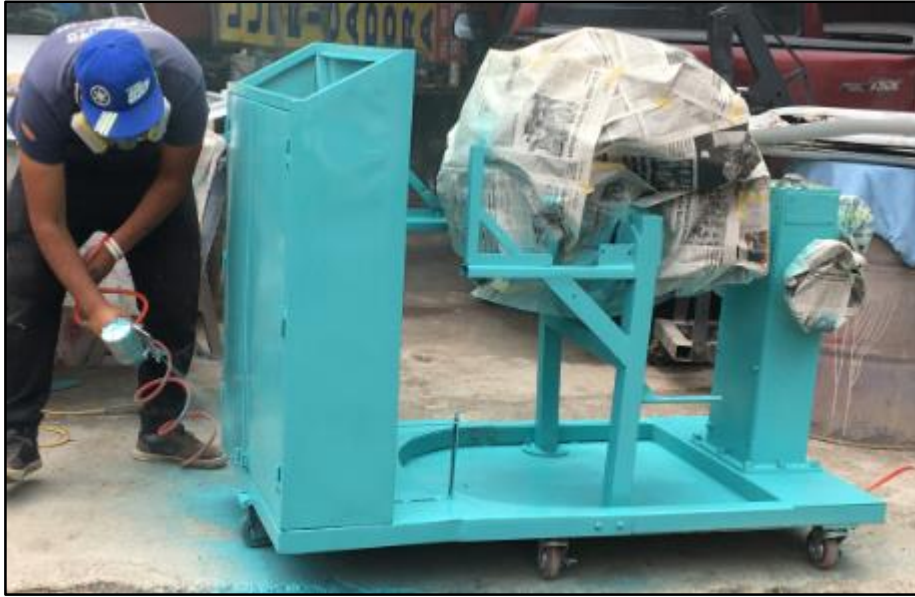
ANEXO 12: Pintado de la estructura
