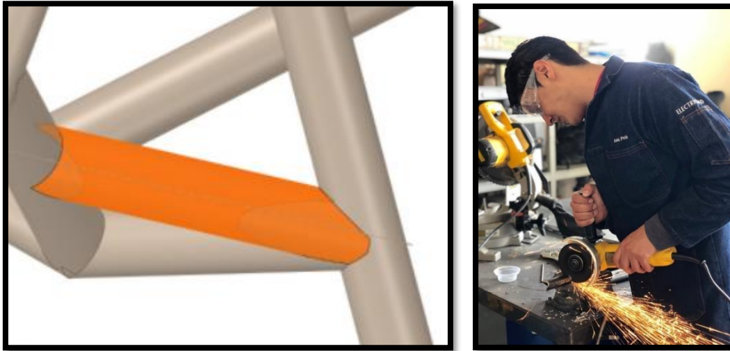
Figura 3.4 Aplicación de plantillas en fabricación de miembros estructurales
