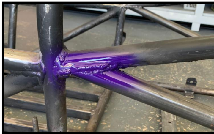
Figura 3.8 Uso de tinta penetrante en cordón de soldadura
