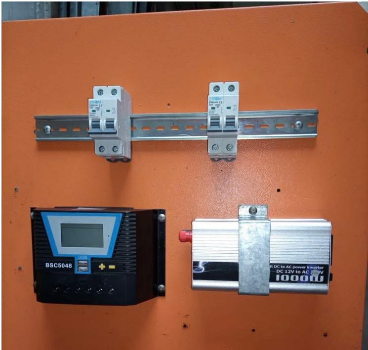
Anexo 6 Armado tablero 1/2
