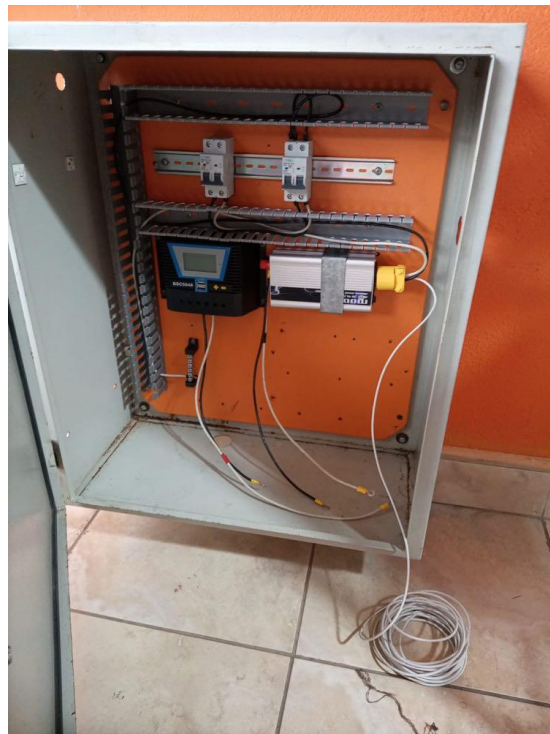
Anexo 8 Instalación del tablero
