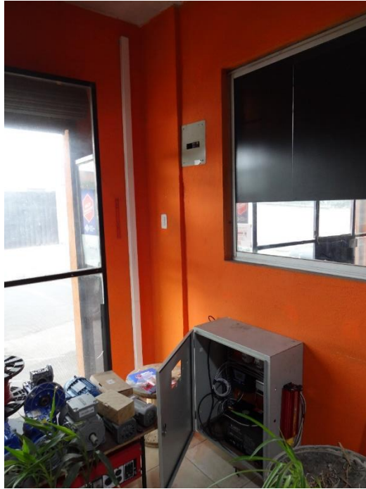
Anexo 11 Instalación, cableado y canaleta.
