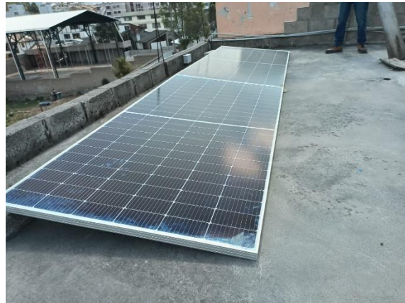
Anexo 10 Instalación panel solar
