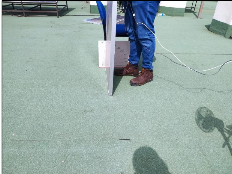
Ilustración 71. Colocación del FV con ángulo de 80^\circ para su respectiva prueba
