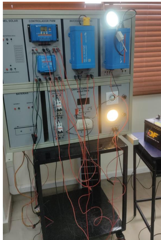
Ilustración 26: Prueba de generación del Sistema Fotovoltaico
