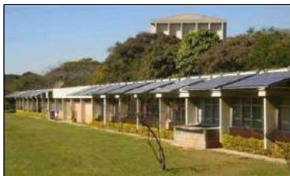
Ilustración No. 6: SFCR sobre el tejado de las viviendas
