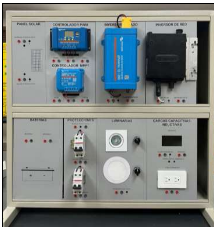
Ilustración No. 31: Módulos instalados en la estructura
