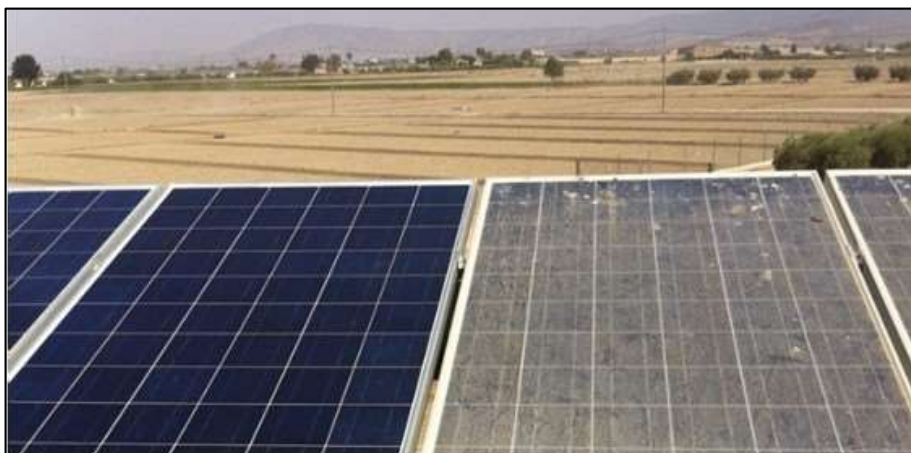
Ilustración No. 24: Panel con presencia de polvo
