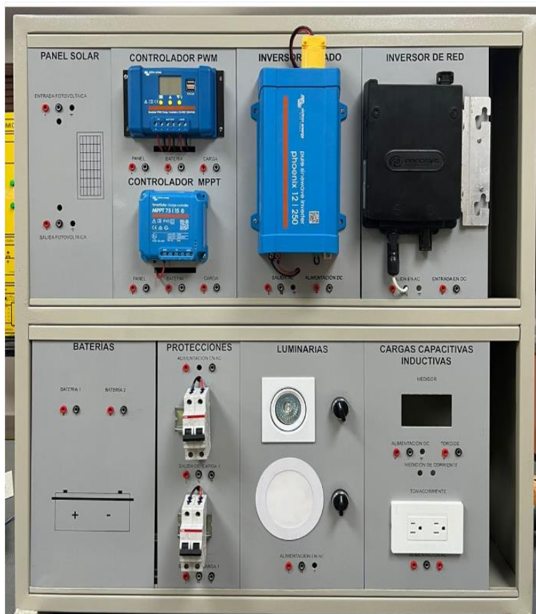
FIGURA. 36 MONTAJE DE EQUIPOS (AUTOR)
