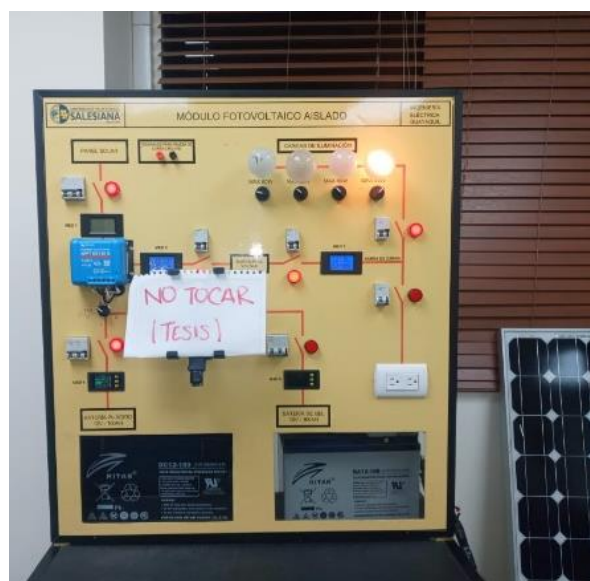
ANEXOS 22 MONTAJE DEL SF EN LAS INTALACIONES DE LA UPS (AUTOR)
