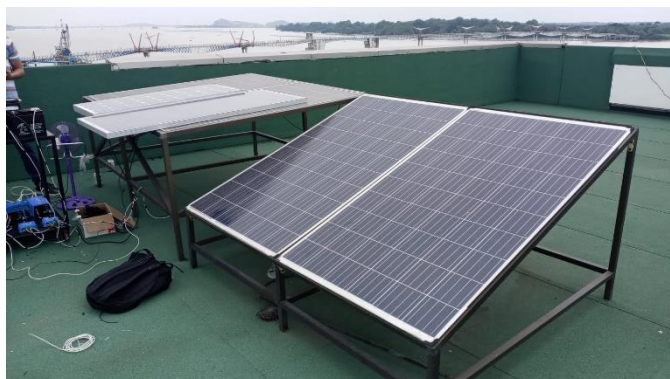
ANEXO 20 CONSTRUCCION DE LOS PANELES UBICACION (AUTOR)
