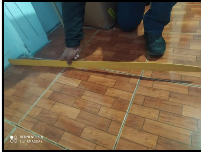
Fotografía 9: Levantamiento de la cerámica en el piso
