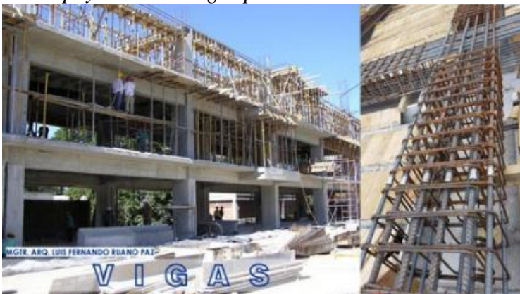
Losa apoyada sobre vigas peraltadas
