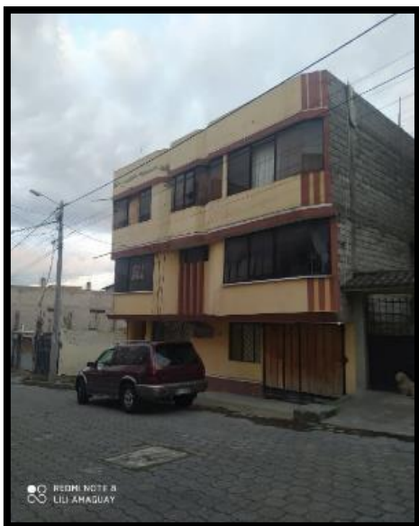
Fachada Frontal de la edificación
