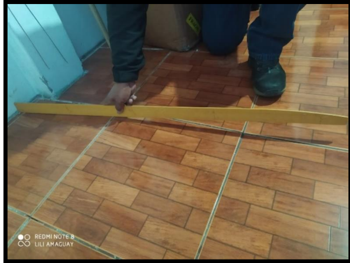
Fotografía 9: Levantamiento de la cerámica en el piso
