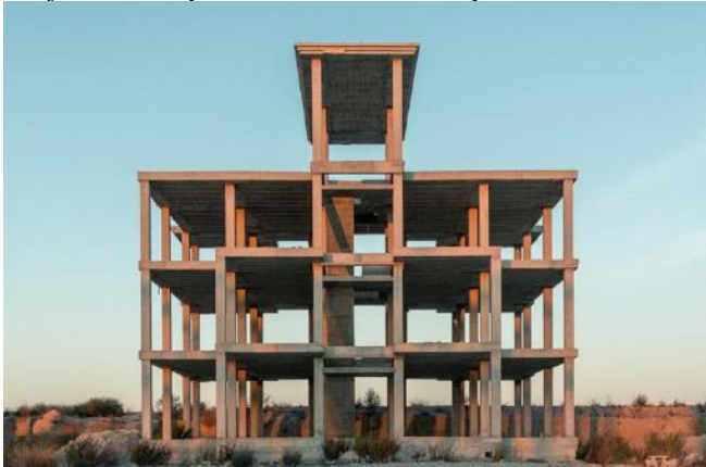
Edificación aporticada con losas planas
