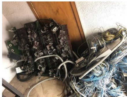
Figura 10. Desmontaje de tablero de control. Los autores
