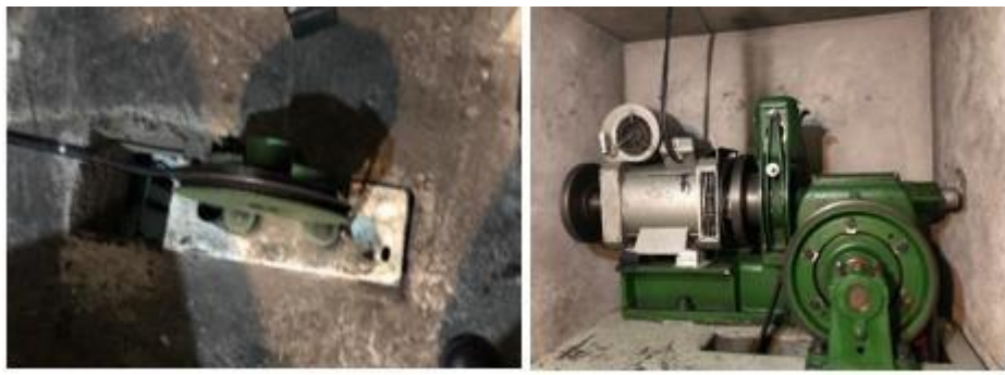
Figura 27. Freno y mantenimiento finalizado del motorreductor. Los autores
