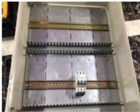
Figura 13. Ensamblaje de rielín y canaleta. Los autores
