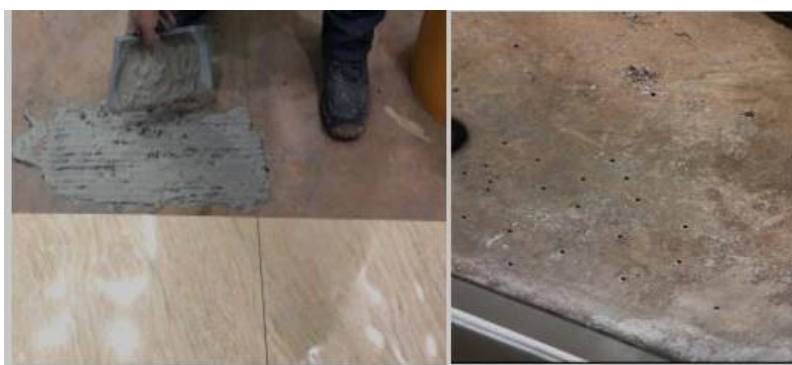
Figura 24. Agujero para adherencia e instalación de porcelanato. Los autores
