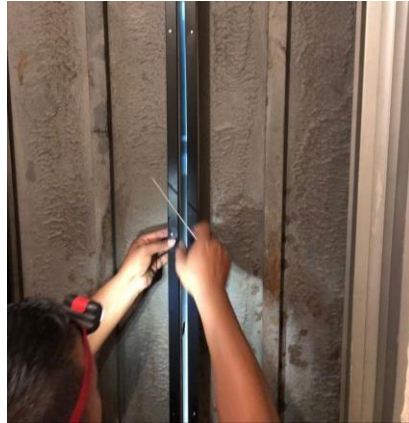
Figura 22. Instalación de rayos de luz en puertas de cabina. Los autores
