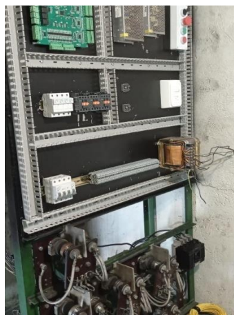
Figura 18. Instalación de tablero de control. Los autores
