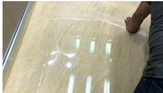
Figura 25. Piso del ascensor terminado. Los autores
