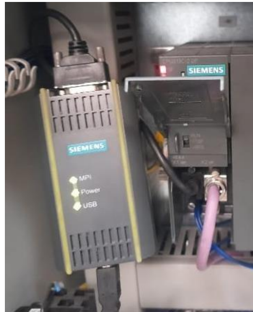
Figura 25: MPI conectado al PLC S7-300.
