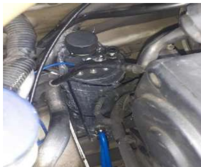
Figura 28.14: Instalación de celda de hidrógeno
