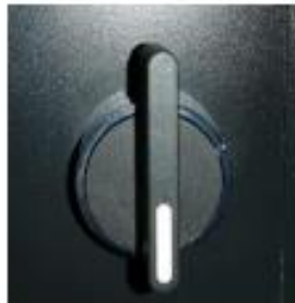
Figura No.10 Interruptor de Encendido y Apagado del extractor de aire
