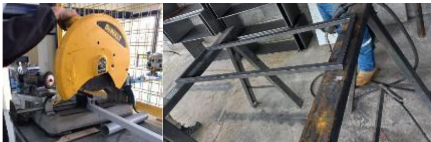
Figura 44. Corte y soldadura de estructura
