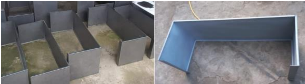
Figura 50. Doblado y pintura de protección posterior
