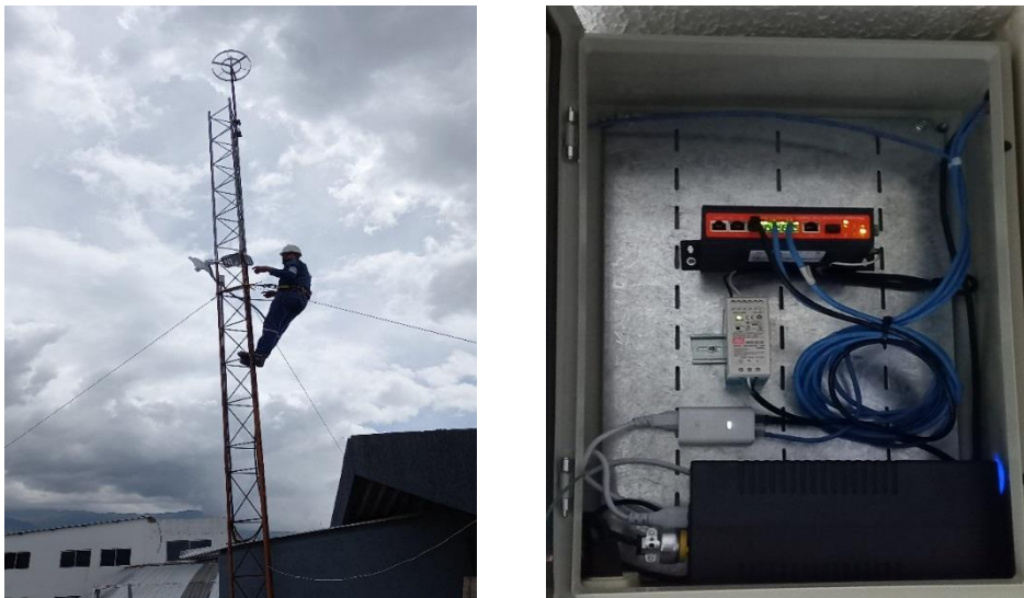
Figura 34. Instalación de antenas.
