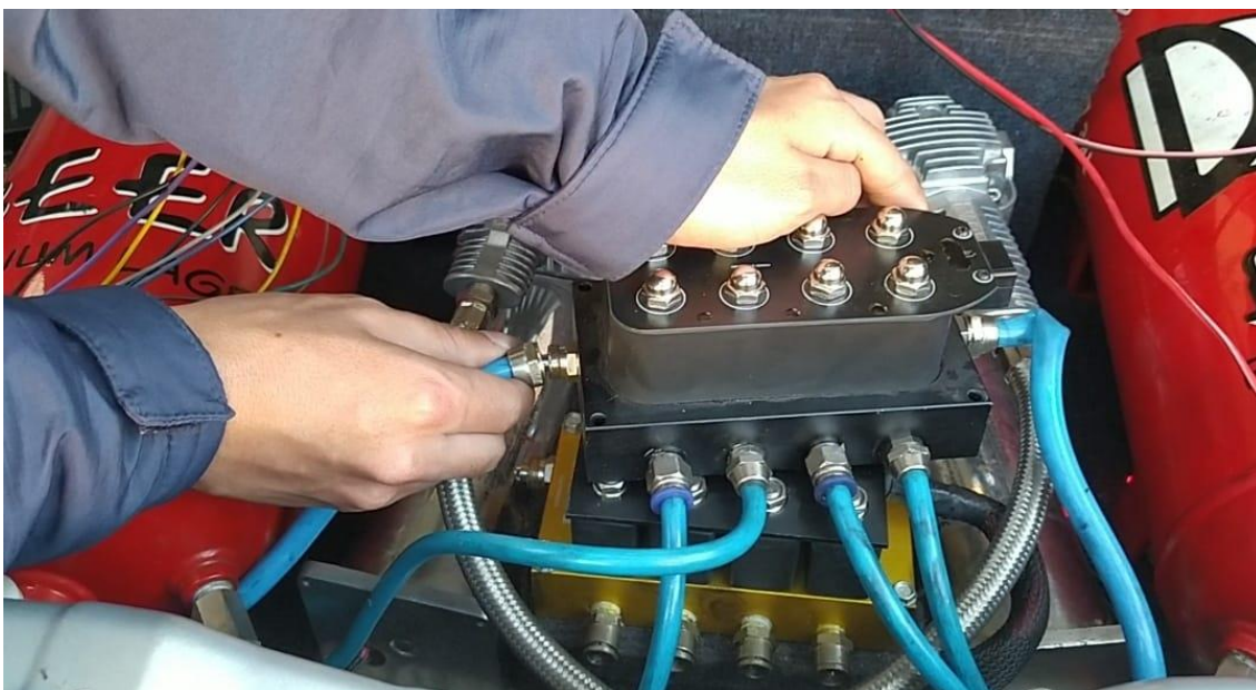
Anexo 36. Instalación de las mangueras con el bloque de válvulas.
