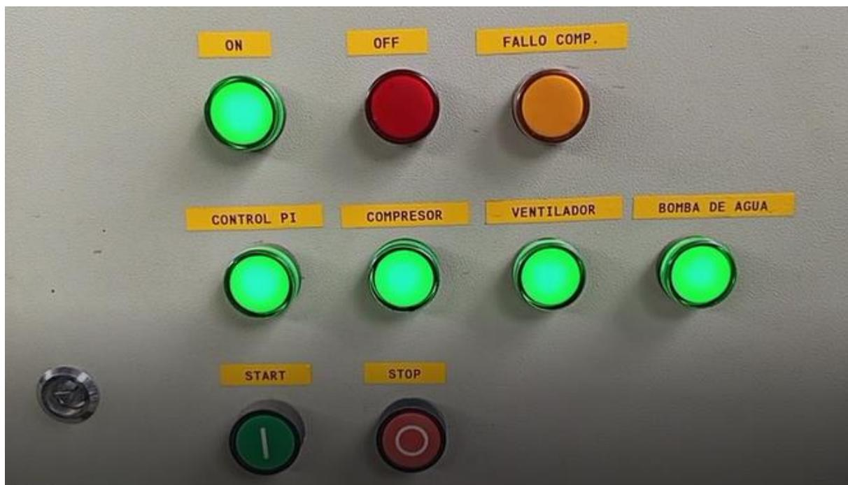
**Figura 65.** Funcionamiento del panel de control del Chiller
