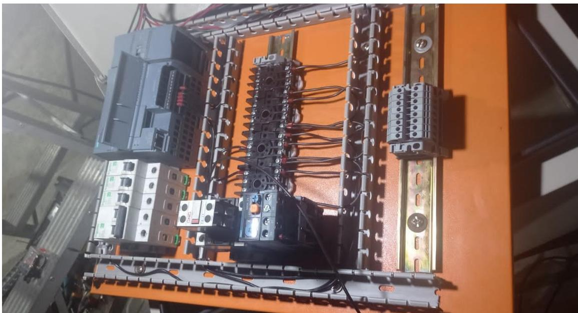
**Figura 22.** Conexión del sistema de relevadores del PLC, sistema contactor y guarda motor
