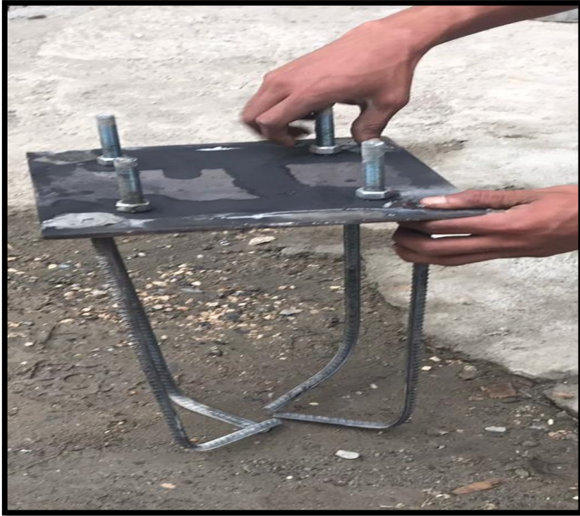
Figura 51: Armada y soldada del soporte a embutir dentro de la tierra excavada, fuente: Los Autores.
