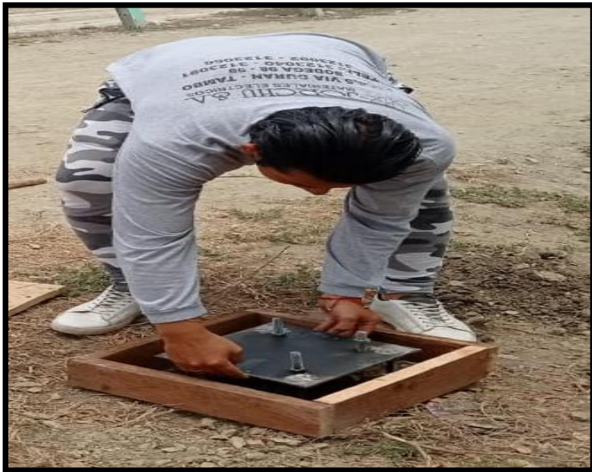
Figura 48: Colocación del muñeco soporte dentro del hueco tipo cajón a fundir, fuente: Los Autores.
