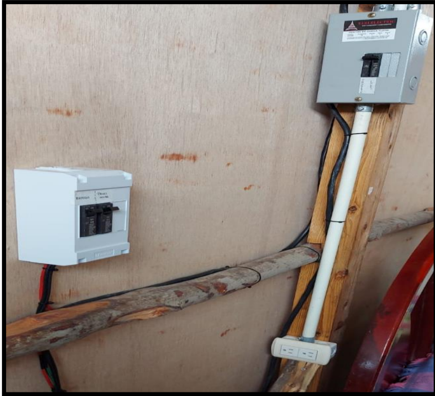
Figura 45: Instalación de un punto de tomacorriente 110v para cargas pequeñas, fuente: Los Autores.
