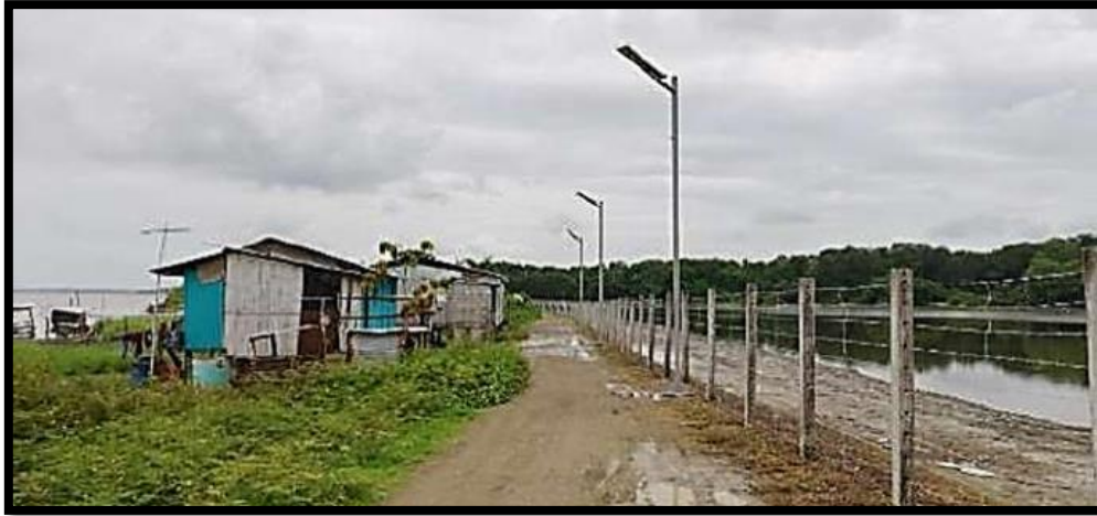
Figura 6: Proyecto alumbrado público implementando sistemas solares fotovoltaicos autónomos, fuente: (Salazar Méndez & Tumbaco González, 2021, pág. 18)
