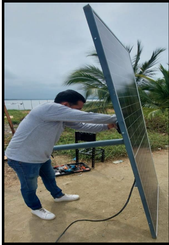
Figura 39: Ajuste de la base del panel fotovoltaico al soporte tipo tubo o poste de anclaje, fuente: Los Autores.
