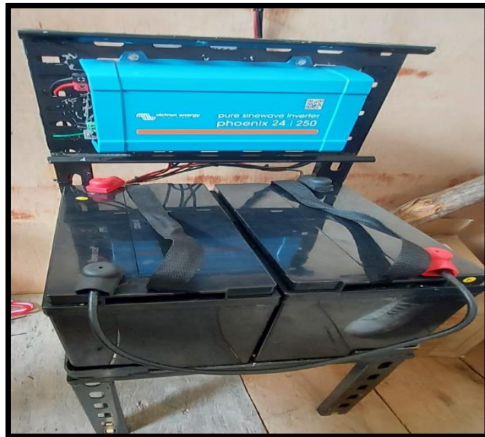
Figura 32: Instalación y puesta de baterías en el soporte tipo banco, fuente: Los Autores.
