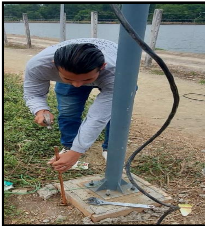
Figura 38: Embutición de su correspondiente varilla a tierra como su respectivo aterrizaje, fuente: Los Autores.
