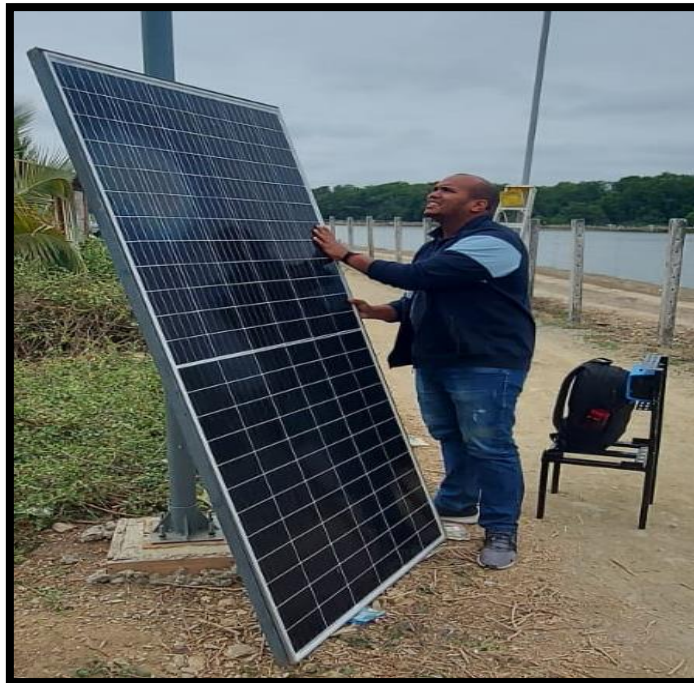
Figura 40: Colocación del panel fotovoltaico en su respectivo soporte metálico, fuente: Los Autores.
