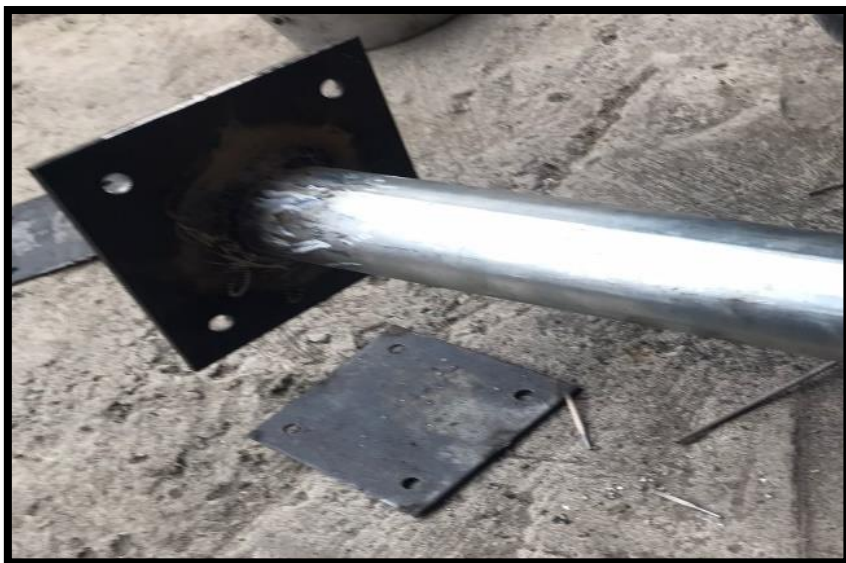
Figura 54: Pulida de las imperfecciones que se realizó luego de soldar en la parte inferior de poste, fuente: Los Autores.
