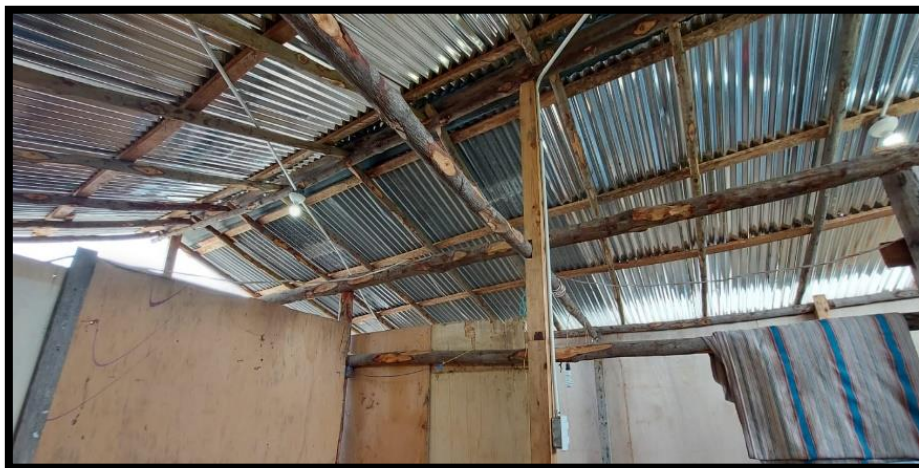
Figura 28: Instalación y cableado estructurado para el sistema eléctrico, fuente: Los Autores.
