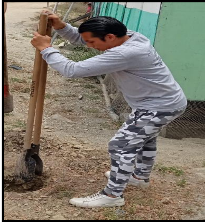
Figura 49: Excavación en el terreno para el soporte del poste, fuente: Los Autores.
