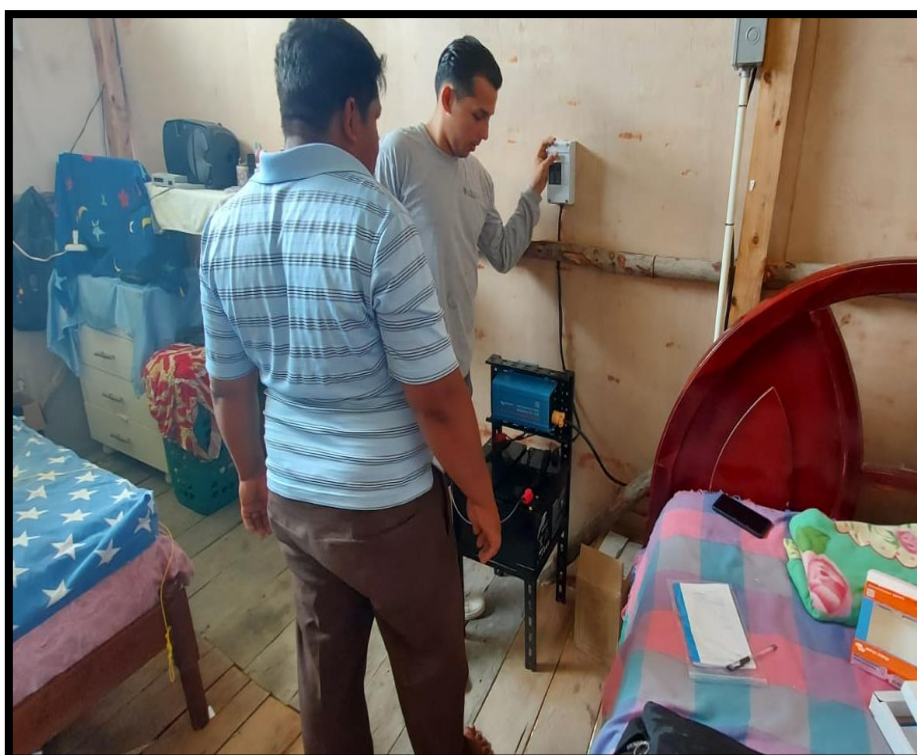
Figura 30: Capacitación para el correcto uso y funcionamiento de los sistemas de protección y del sistema fotovoltaico, fuente: Los Autores.
