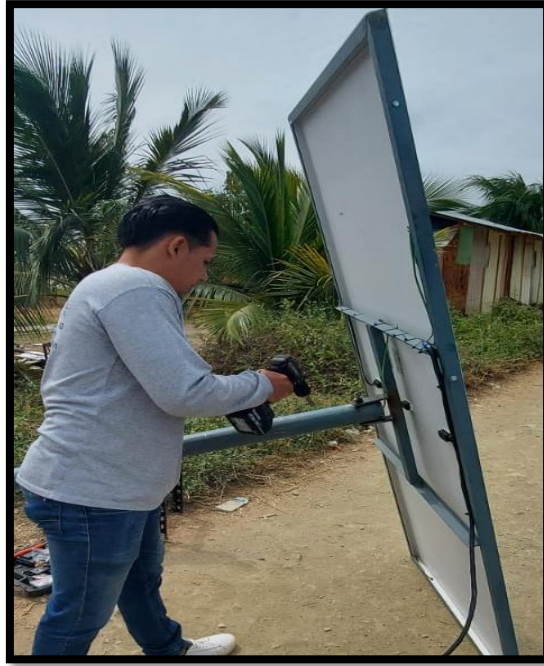
Figura 41: Instalación y acople del poste con el soporte del panel fotovoltaico, fuente: Los Autores.
