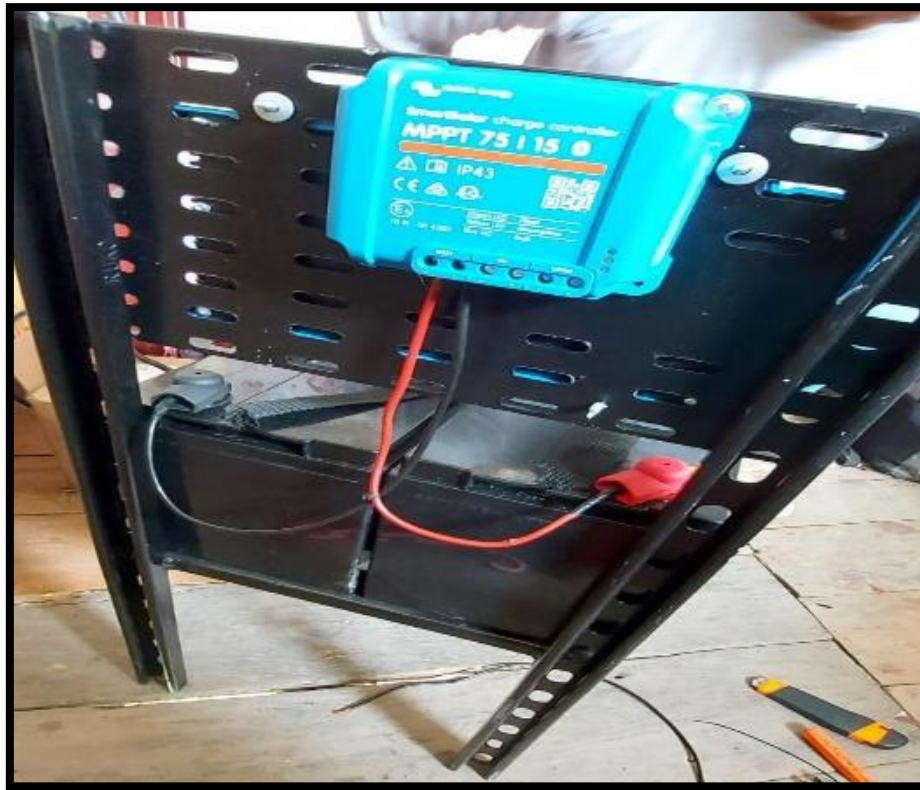
Figura 35: Montaje y conexión del controlador de carga del sistema fotovoltaico, fuente: Los Autores.
