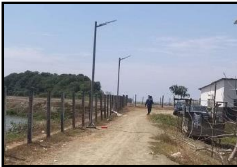
Figura 8: Instalación del poste de alumbrado público en el recinto masa 2, fuente: (Guerrero Santana & Catagua Mera, 2020, pág. 103).
