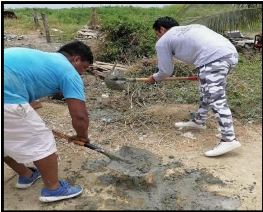
Figura 46: Mezcla de arena y cemento para la base que soportará el panel Fotovoltaico, fuente: Los Autores.
