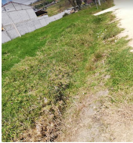
Figura 54: Estado Actual de las acequias
