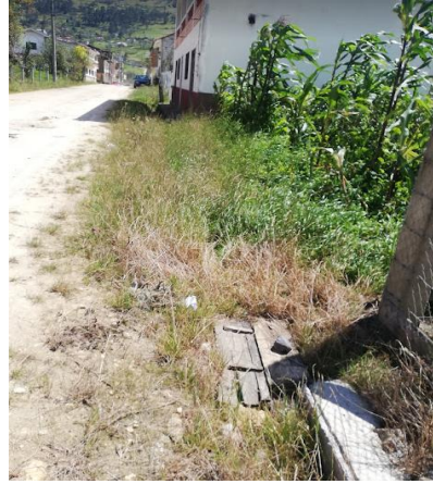
Figura 55: Estado Actual de las acequias
