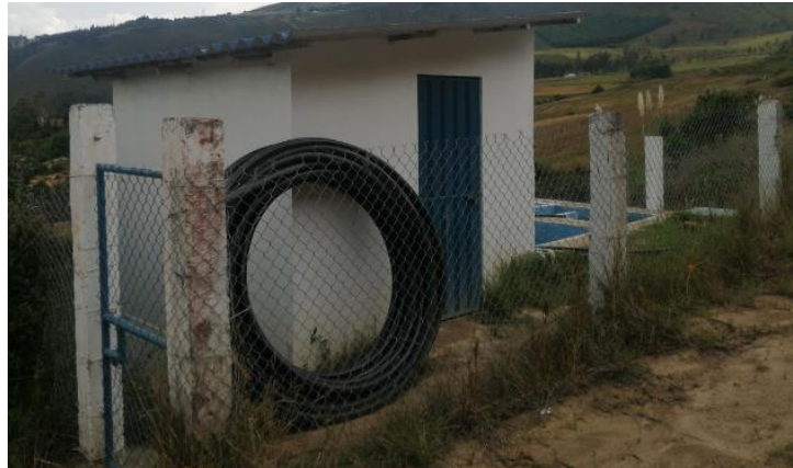
Figura 16 Mangueras de PVC expuestas a condiciones meteorológicas en la planta de tratamiento de agua potable Chuilla.
