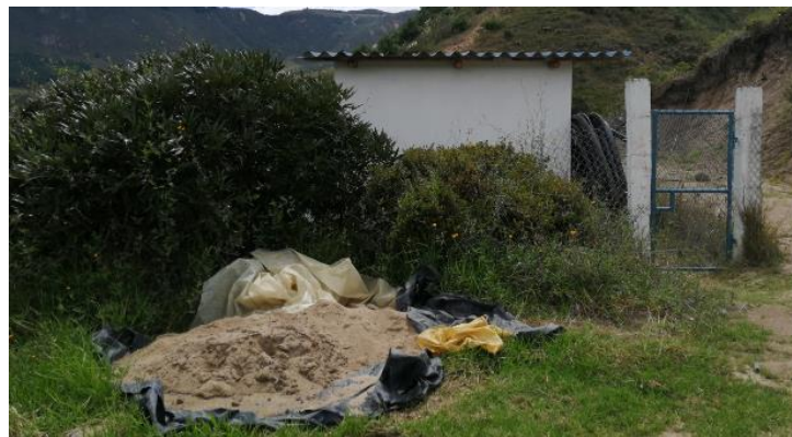
Figura 15 Plásticos protectores de arena de filtración cerca de la planta de tratamiento de agua potable Chuilla.
