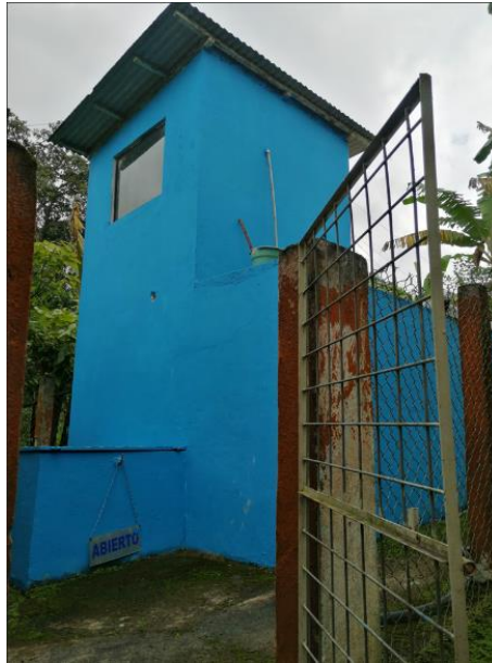
Figura 40 Planta de Tratamiento de Agua Potable que pertenece a la JAAP Vivar Bajo
