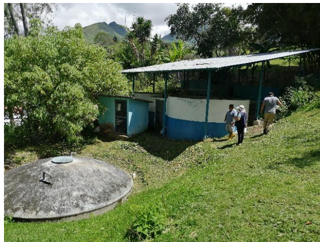
Figura 36 Planta de Tratamiento de Agua Potable de la JAAP Portovelo Grande.
