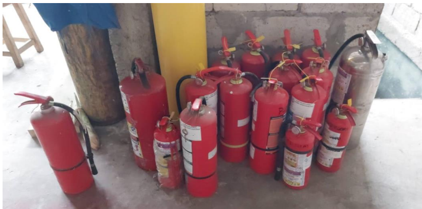
Figura 46: Inspección de extintores
