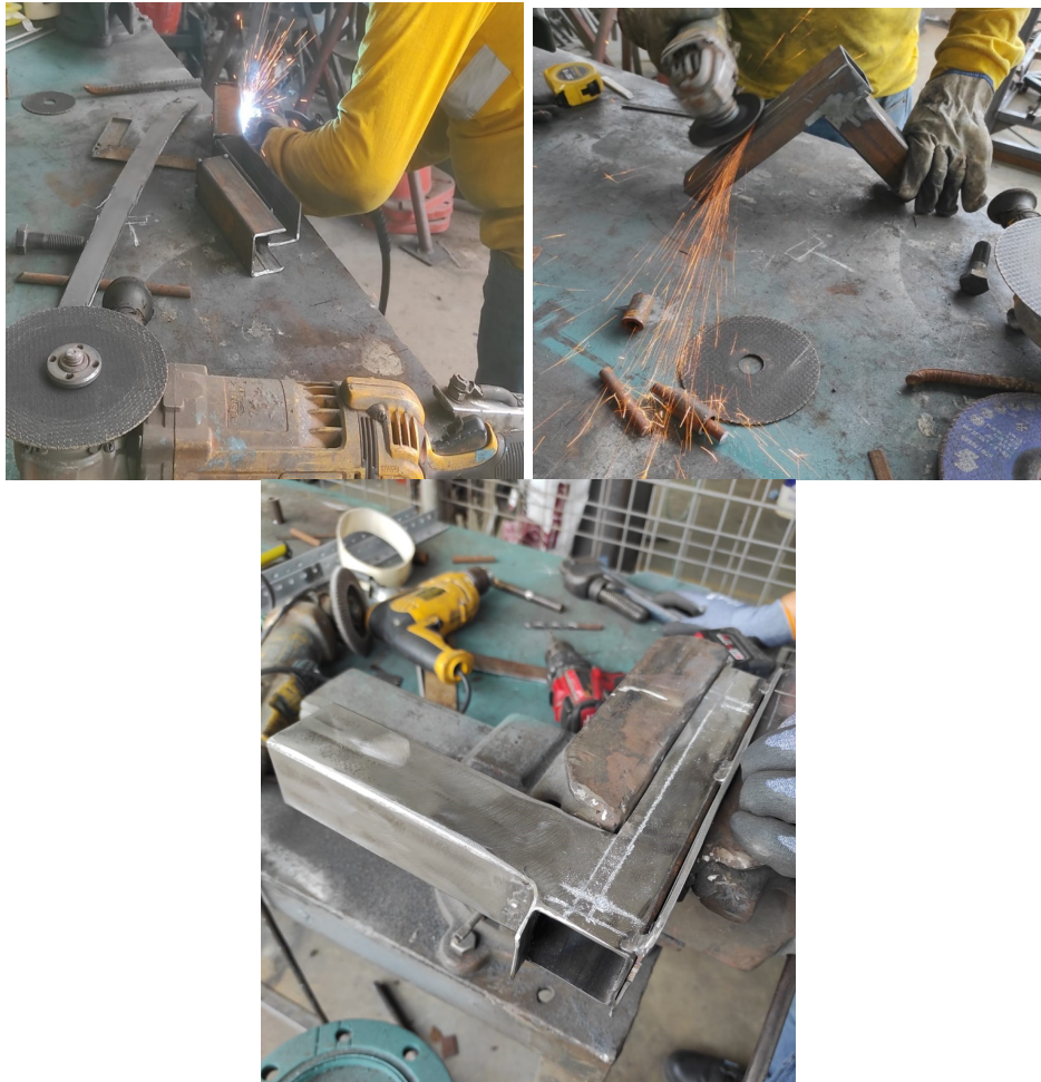
Figura 23. Fabricación de estructura
