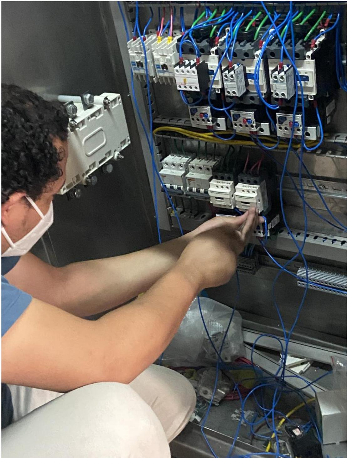
Figura 93. Instalación de componentes eléctricos en panel de control
