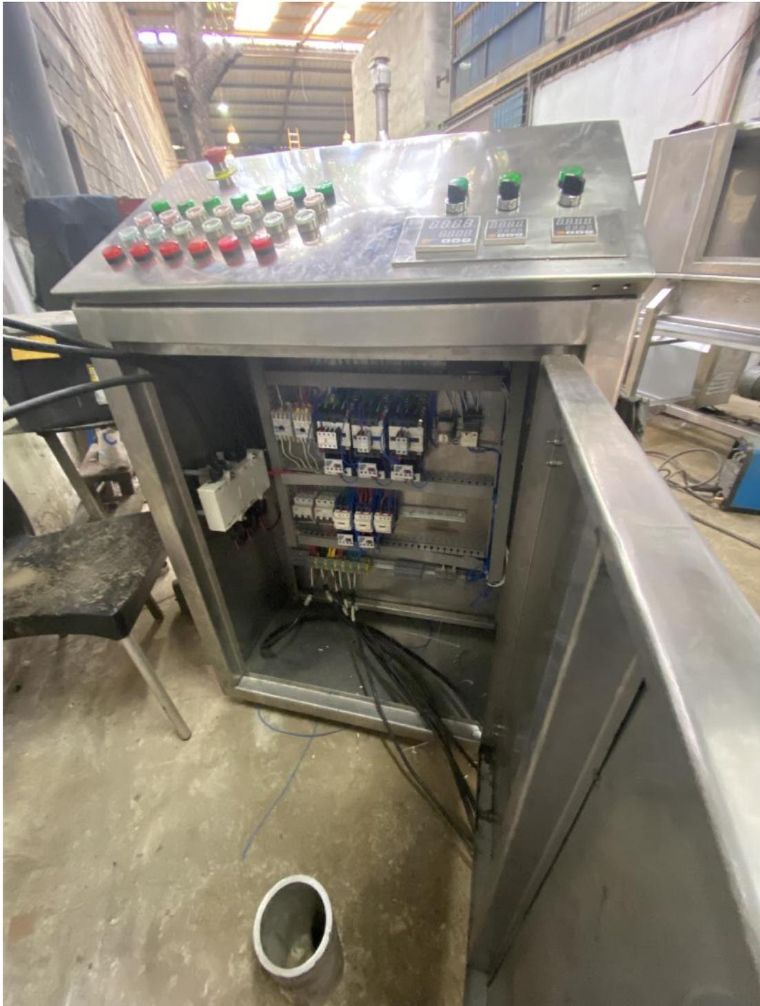
Figura 96. Peinado de cableado de panel eléctrico
