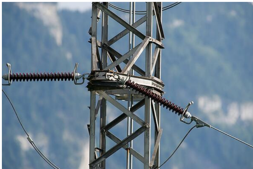
Figura 10: Aisladores tipo barra [11]
