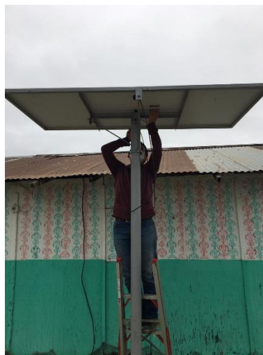
Figura 36 Instalar el panel solar
