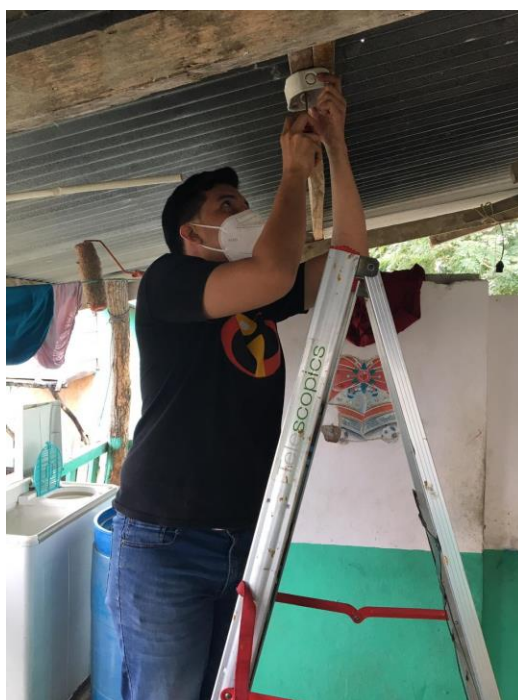
Figura 44 Instalación de conexión de tubería, boquillas, cajas de paso y tomas corrientes
