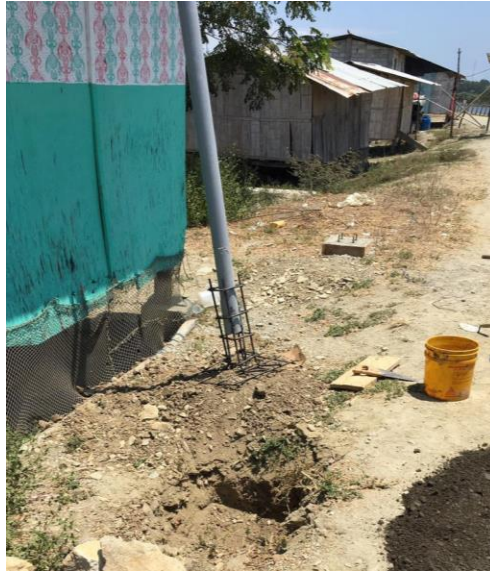
Figura 35 Instalación de poste para panel Fotovoltaico
