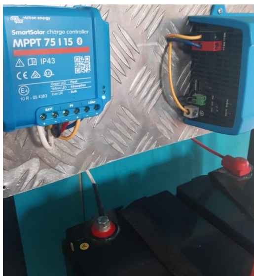
Figura 39 Instalación y conexión de controlador, inversor y baterías
