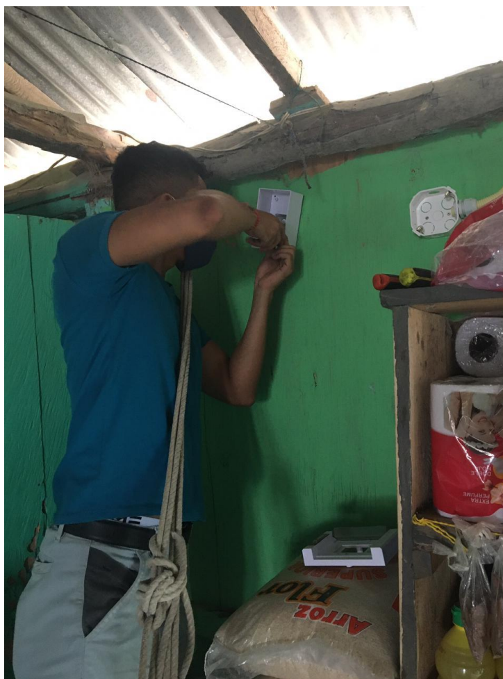
Figura 45 Instalación de breaker principales
