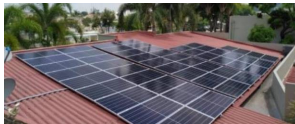
Figura 9 Paneles Solares instalados en techo
