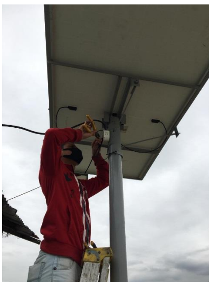
Figura 37 Conexión de panel solar
