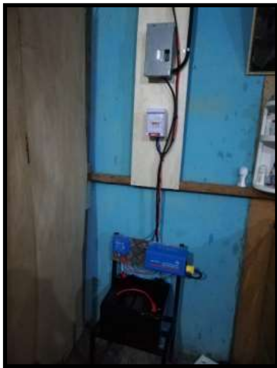
Figura 37: Sistema fotovoltaico instalado dentro del hogar de la familia beneficiada, fuente: Autores.
