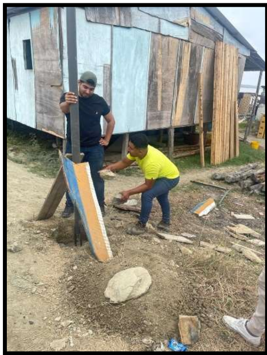
Figura 53: Fundición de concreto para soporte de panel solar por Autores de tesis, fuente: Autores.
