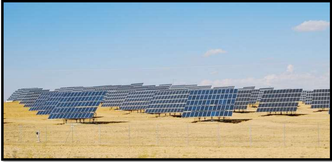
Figura 8: Paneles solares fotovoltaicos, fuente: (Martínez, 2021).
