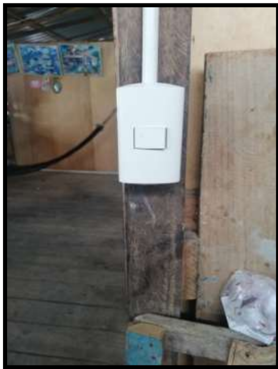
Figura 41: Interruptor de circuito de luz correctamente instalado, fuente: Autores.
