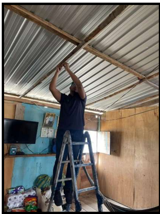
Figura 46: Montaje de puntos de tomacorriente por tubería PVC, fuente: Autores.
