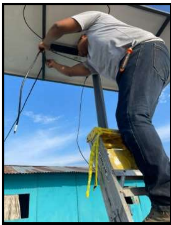
Figura 35: Conexión de cables de alimentación del panel, fuente: Autores.
