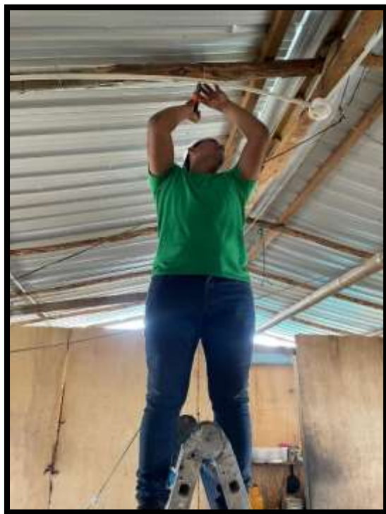
Figura 47: Ajuste de tubería PVC con caja rectangular 4x4, fuente: Autores.
