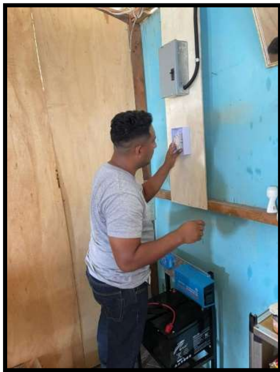
Figura 51: Instalación de protecciones para sistema fotovoltaico, fuente: Autores.
