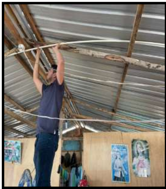
Figura 45: Instalación de la Tubería PVC, fuente: Autores.
