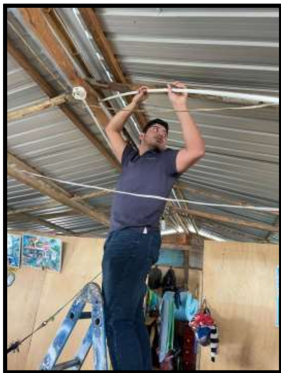
Figura 43: Medición de tubos para previa instalación, fuente: Autores.
