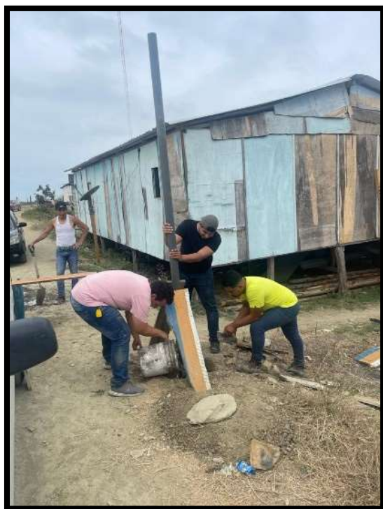
Figura 53: Fundición de concreto para soporte de panel solar por Autores de tesis, fuente: Autores.
