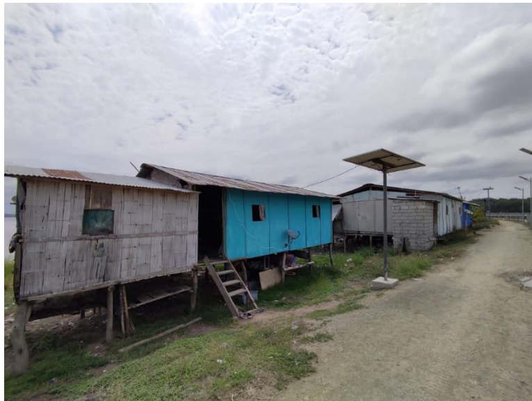
Figura20. Instalación final del panel solar fuera de la vivienda beneficiada
