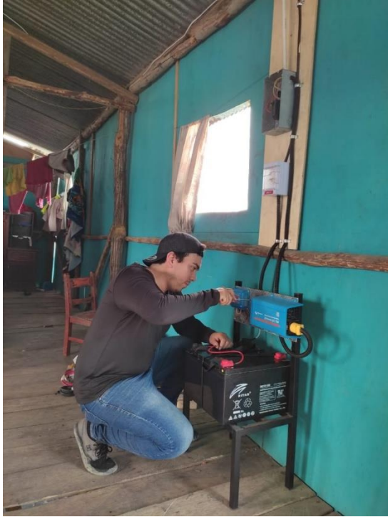
Figura18. Instalación de protecciones
