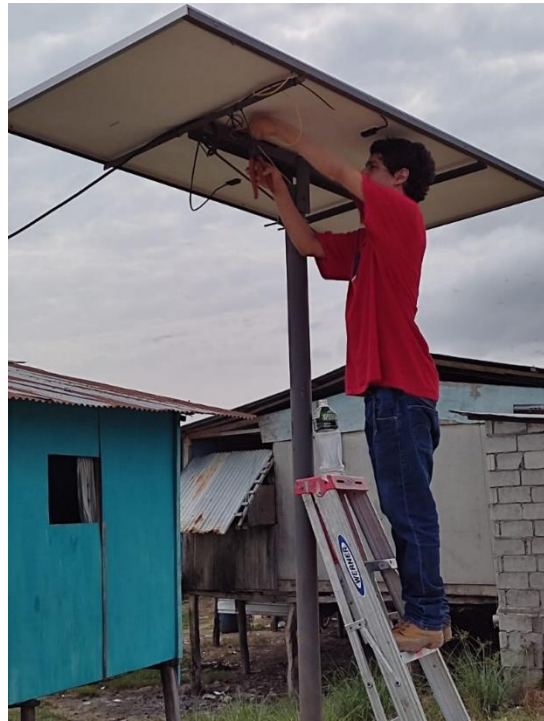
Figura19. Instalación del panel solar
