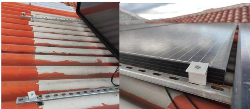
Ilustración 22. Estructura de soporte y fijación.
