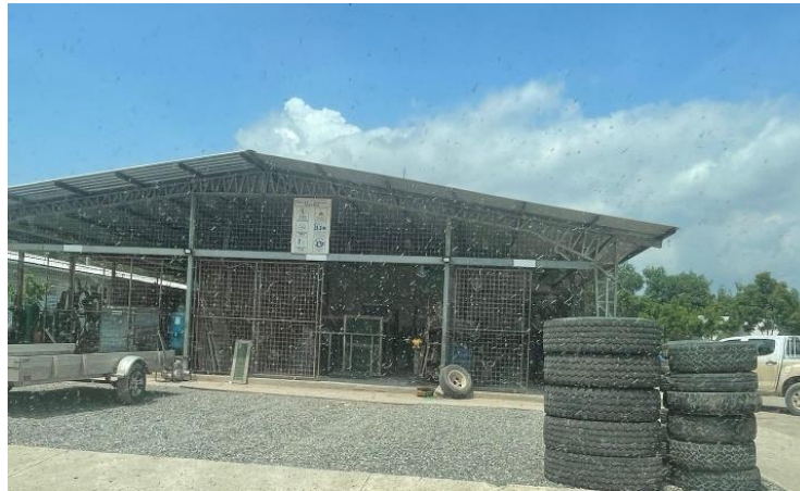
Figura 3. Área de mantenimiento
