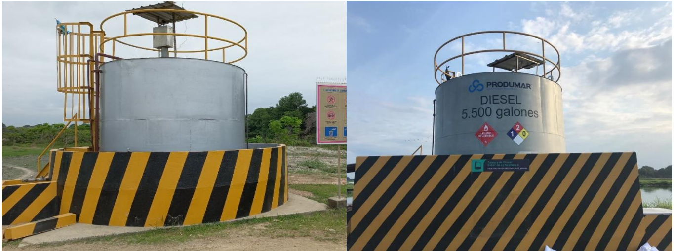
Figura 10. Antes y después del área de distribución de Diesel
