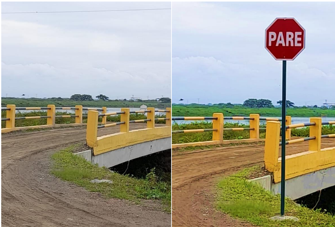
Figura 9. Antes y después de ruta 1, sector La Delia
