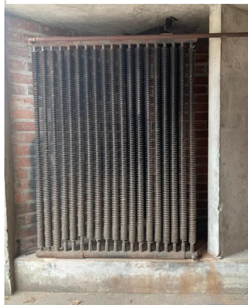
Ilustración 23. Mantenimiento de radiadores
