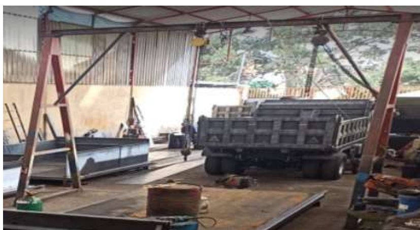
Figura 10. Montaje del balde de volqueta mediante un tecele manual de rotación de 10 toneladas
