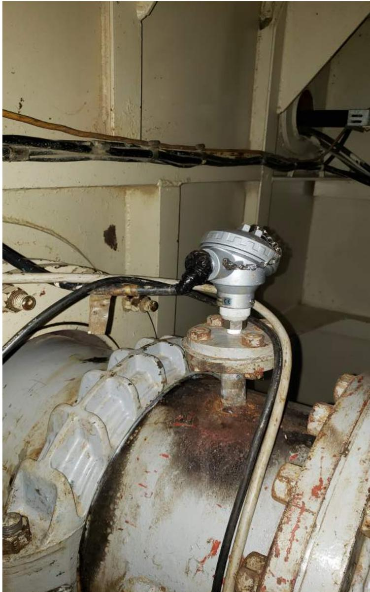
Figura 49: Sensor de Salida
