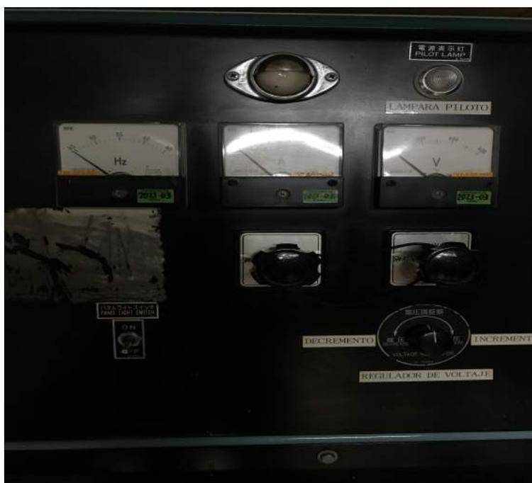
Figura 23: Indicadores del Generador de Emergencia
