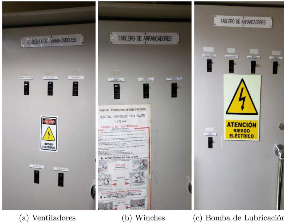
Figura 19: Tablero de Arrancadores de los Winches, Bomba de Servicio, Lubricación de Bomba de Descarga
