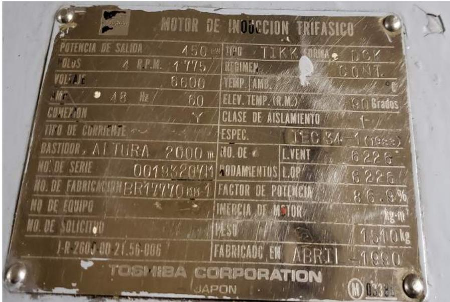
Figura 46: Placa de Motor de Bomba de Descarga
