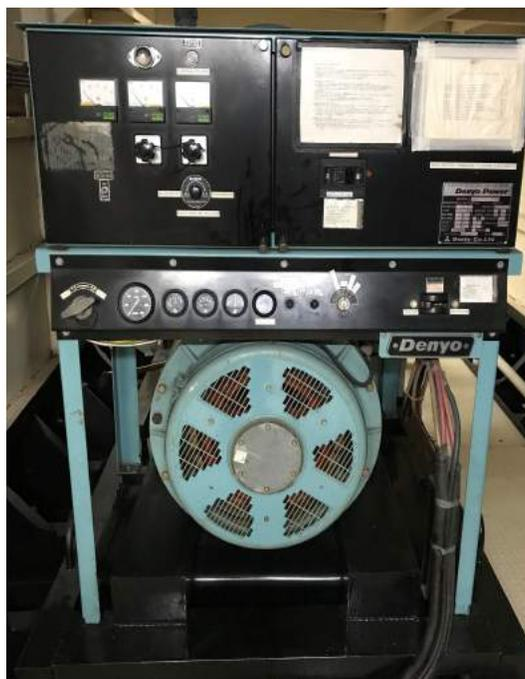
Figura 22: Generador de Emergencia
