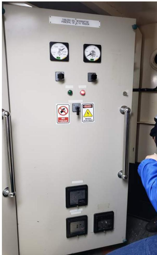
Figura 12: Tablero del Interruptor Principal de Alta Tensión
