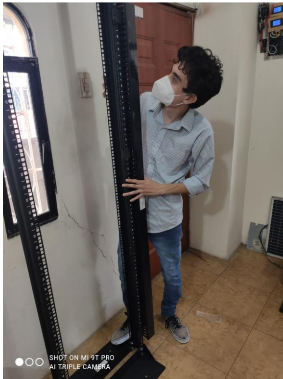
Figura 4.6 Armado de organizadores verticales
