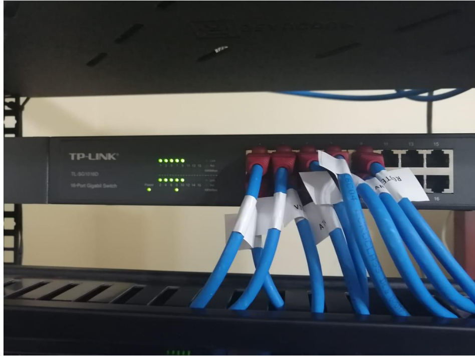
Figura 4.27 Conexiones del Switch
