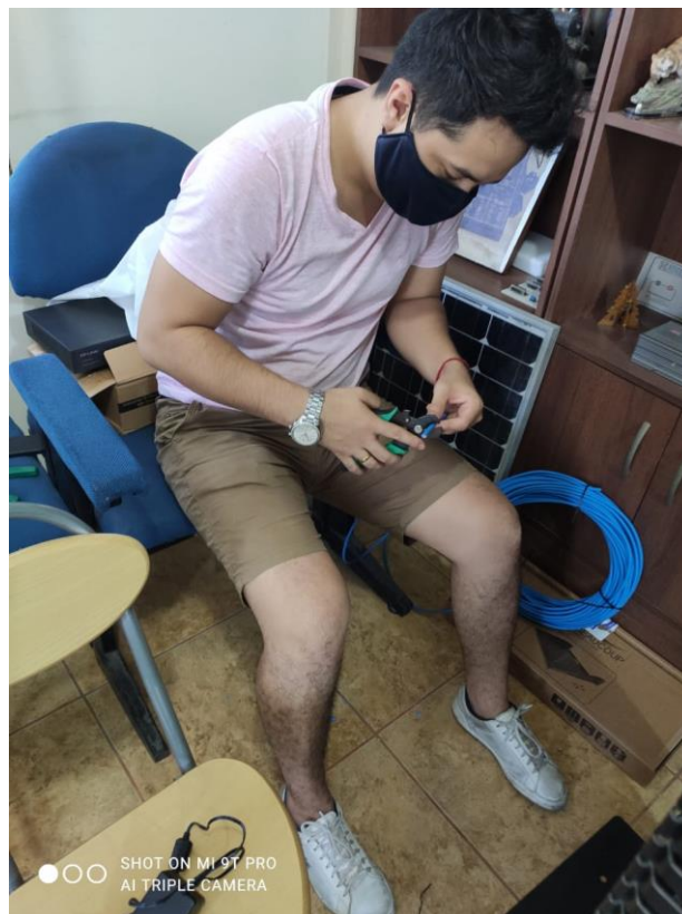
Figura 4.8 Realización de cables UTP y patchcords
