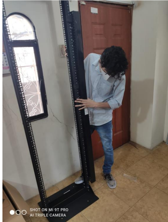
Figura 4.4 Armado de los parantes del rack
