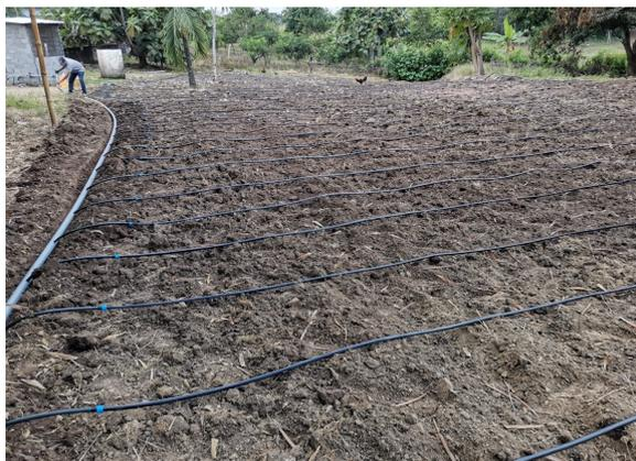
(e) Soterramiento de la tubería secundaria.
