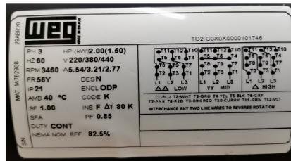
**Fig. 44** Placa de la bomba eléctrica. Autores.
