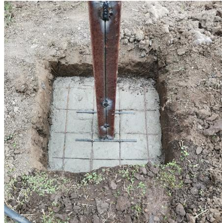
(c) Cimentación de estructura de bomba.
