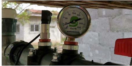
**Fig. 55** Presión de trabajo a lazo abierto.
