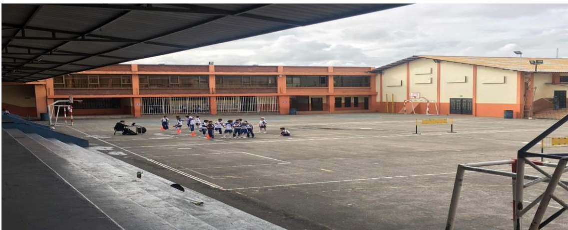
Figura 25. Infraestructura Física de la Unidad Educativa Técnico Salesiano, Campus Carlos Crespi.
