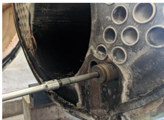
Figura 29. Ajuste de tubos de fuego con la herramienta expensor.
