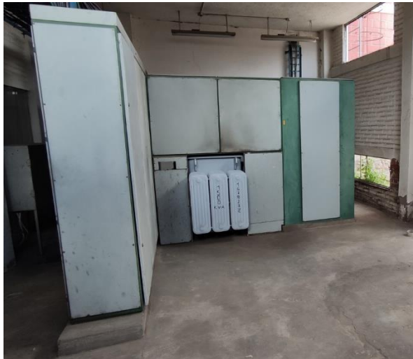
Figura 32. Transformador 1.5 MVA sección Polyalgon
