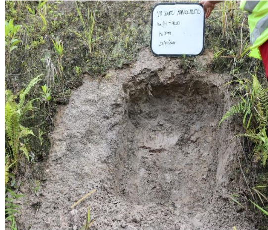
Figura 4. Extracción de bloque de suelo ubicada Vía Nanegalito sector Los Dos Puentes.
