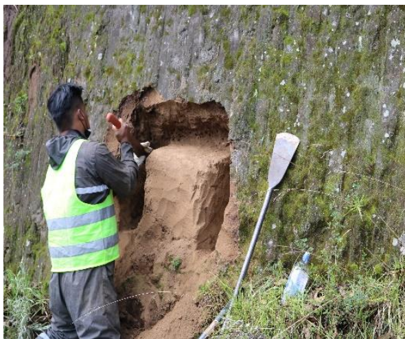
Figura 3. Extracción bloque de suelo ubicada Vía Nono sector Plan Techo
