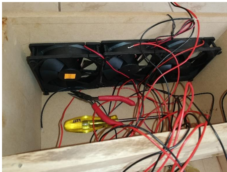
Anexo 4: Instalación de tres (3) ventiladores que insertaran una cantidad de viento para crear la diferencia de temperatura.
