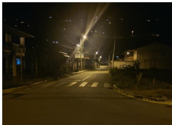
Figura 1.3: Baja uniformidad en la vía y producción de efecto cebra Fuente[Propio]
