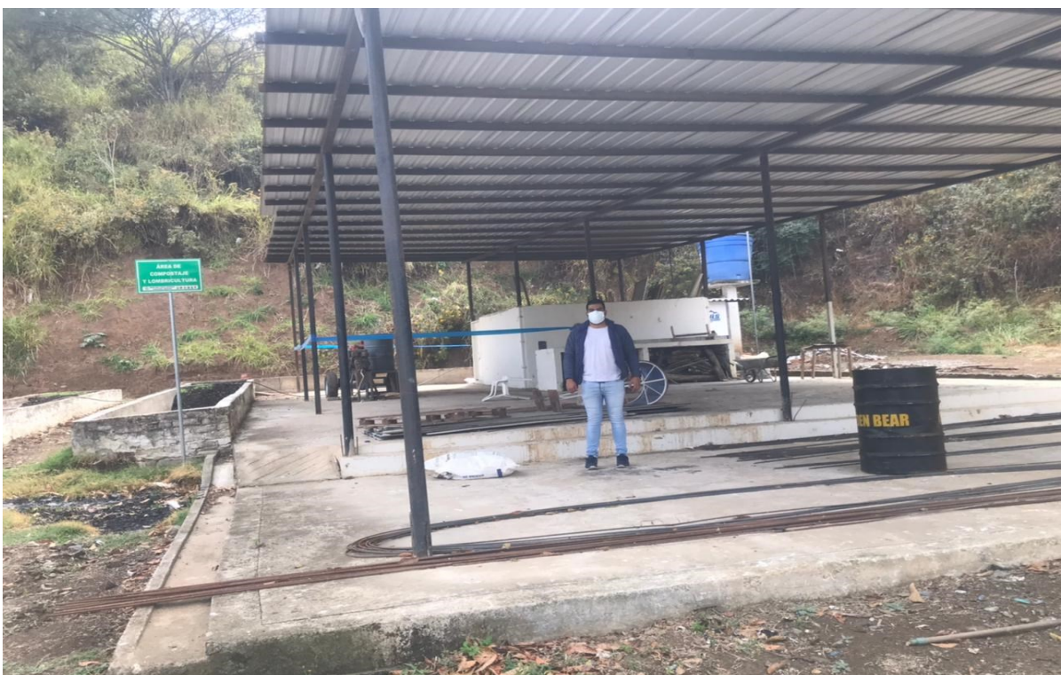
Figura 24: Reconocimiento de instalaciones donde se realiza cuarteo y caracterización de los desechos sólidos generados en el cantón Paltas.
