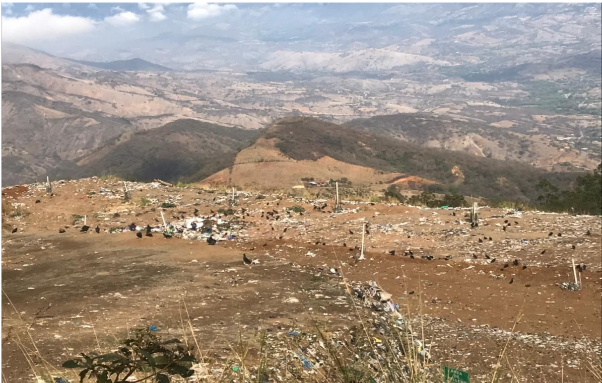
Figura 23: Estado actual de relleno sanitario del cantón Paltas.
