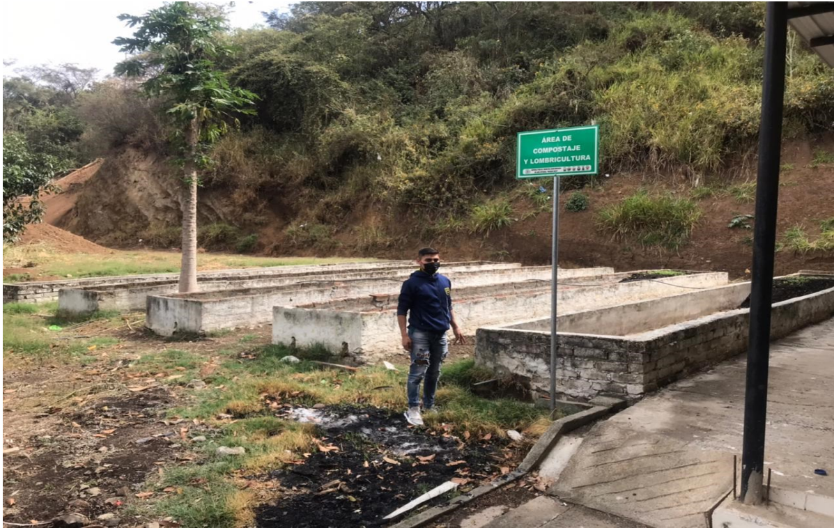
Figura 25: Reconocimiento de instalaciones del relleno sanitario, camas composteras deshabilitadas.
