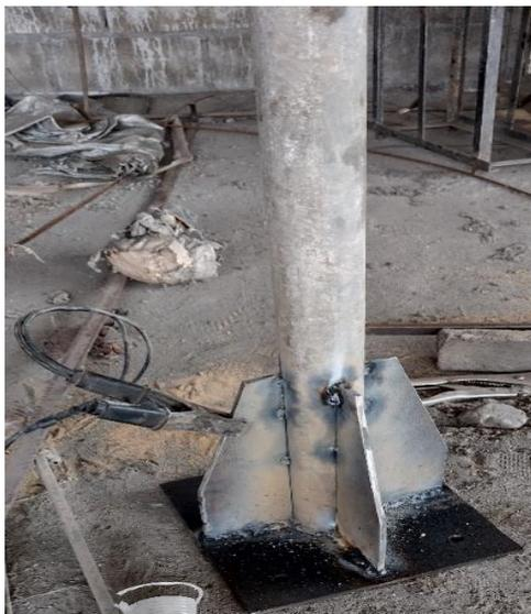
Figura 43 Soldadura de poste / base
