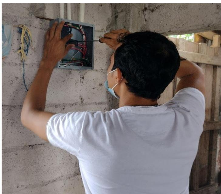
Figura 37 Instalación, cableado y brequeado del centro de carga
