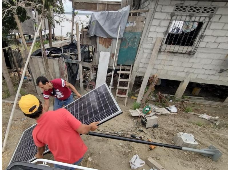
Figura 47 Montaje del panel solar en la estructura
