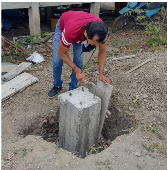
Figura 46 Desencofrado de plinto
