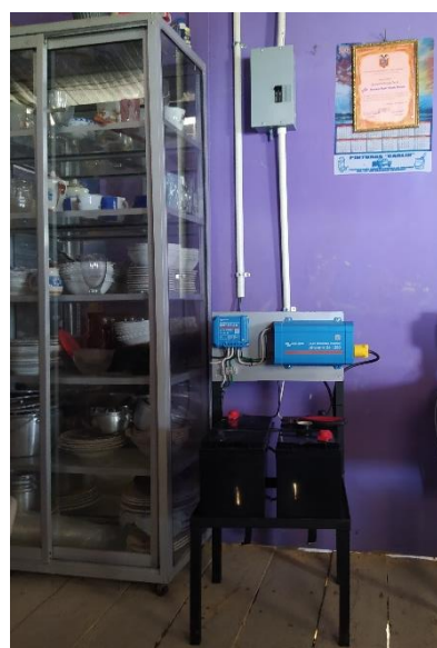
b) Instalación finalizada
