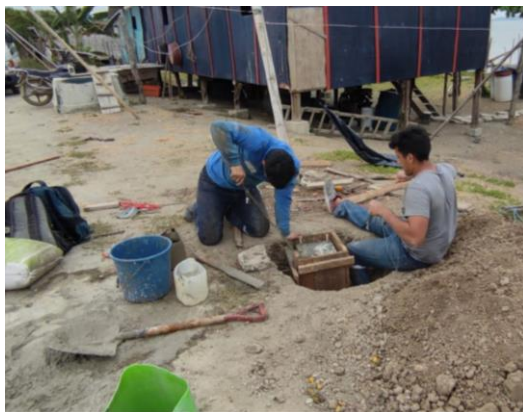
c) Fundición del plinto
