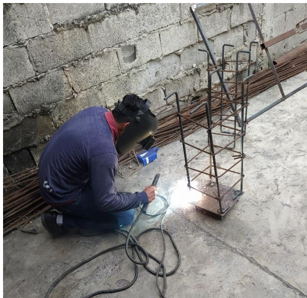
Ilustración 29. Fabricación de la estructura del plinto Fuente: Autor
