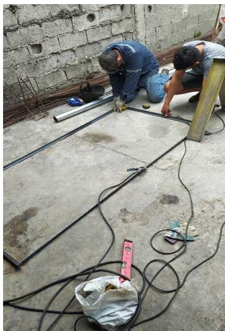
b) Construcción de la base
