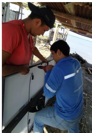
b) Fijación del panel a la base
