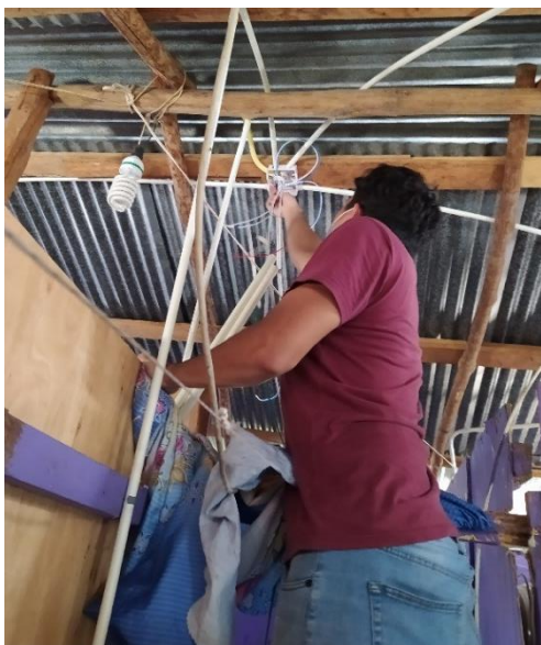
a) Cableado del circuito de tomacorrientes
