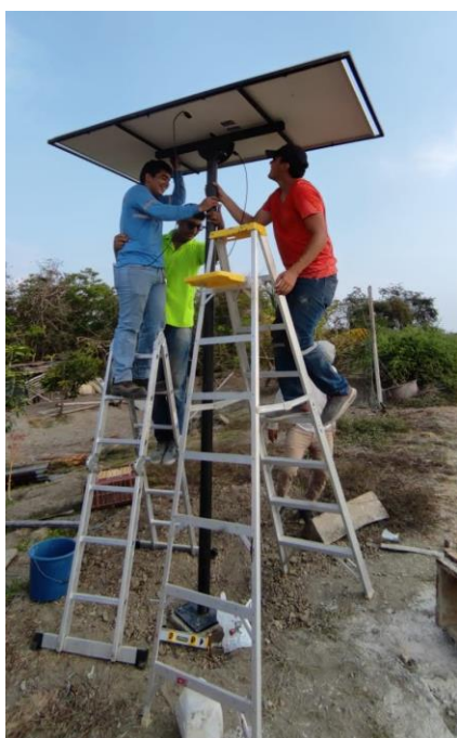
c) Montaje del Panel en la base
