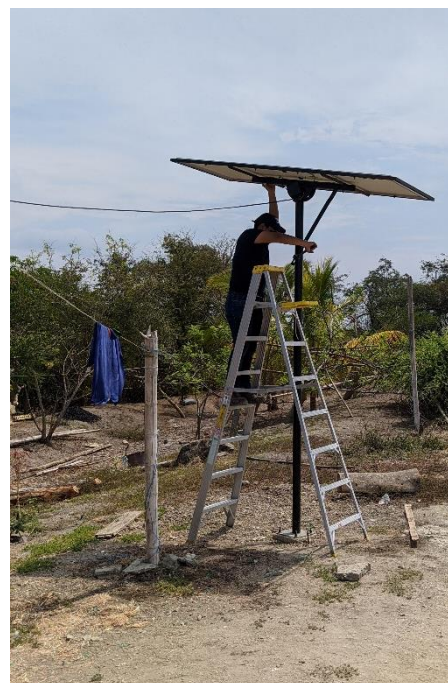
d) Ajuste del Angulo de inclinación
