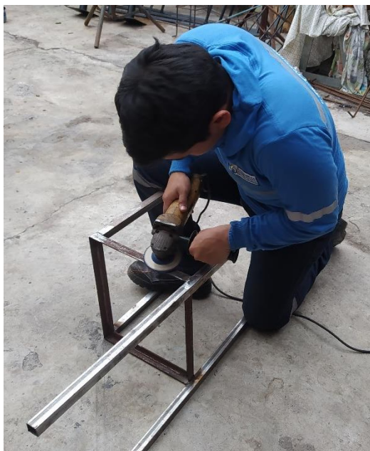
a) Construcción de la base de baterías
