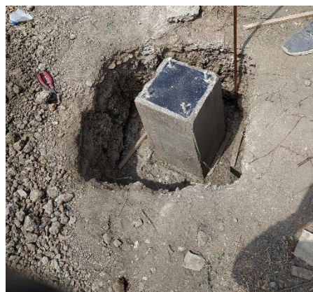
d) Plinto terminado
