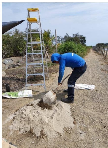
b) Mezcla para el plinto
