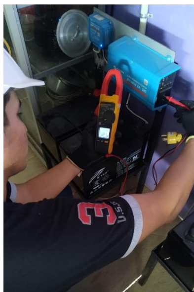
a) Medición de voltajes y corrientes del sistema
