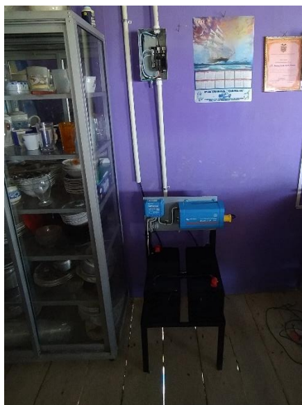
a) Instalación y conexión al panel de distribución
