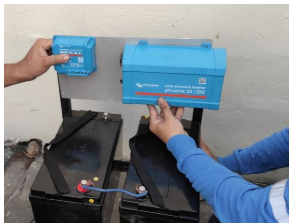
b) Prueba de los equipos en las bases construidas
