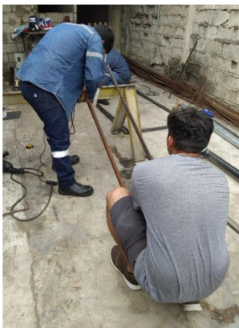
a) Construcción de la base
