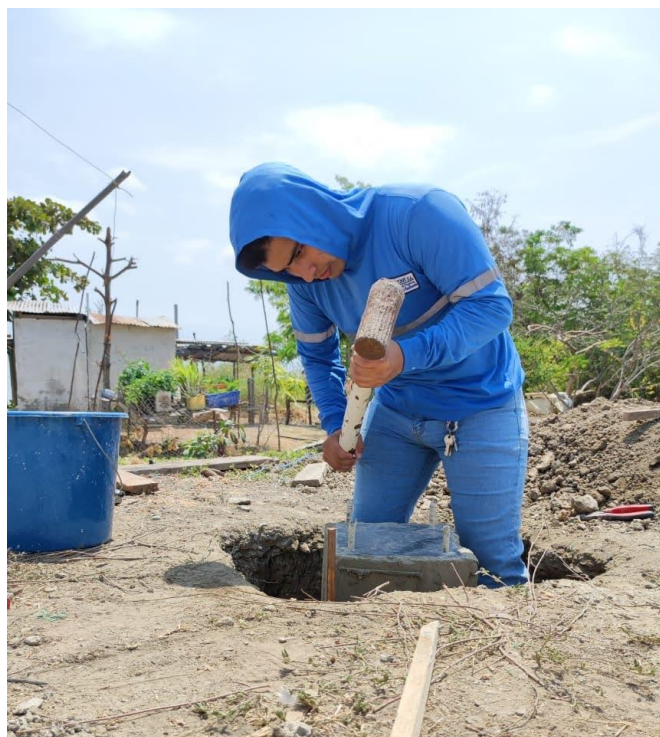
Ilustración 31. Instalación de varilla de puesta a tierra. Fuente: Autor
