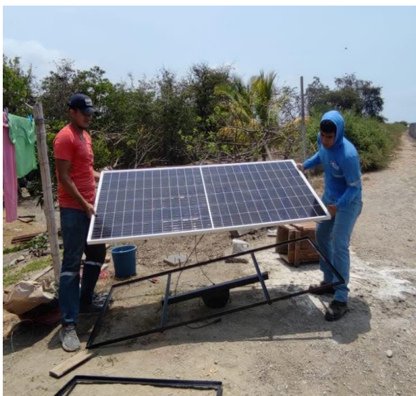
a) Colocación del panel en la base
