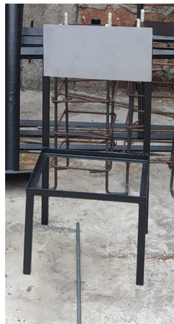
b) Base de baterías terminada
