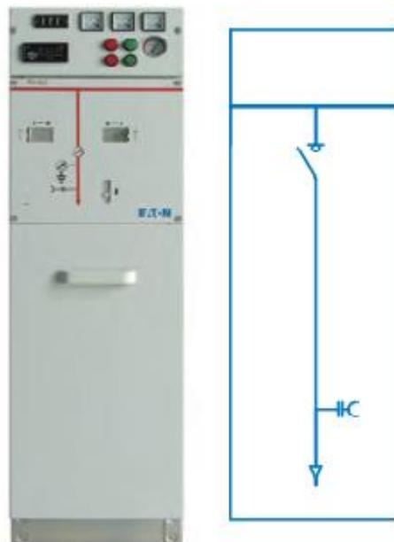
**Figura 10: Celda de seccionamiento**
