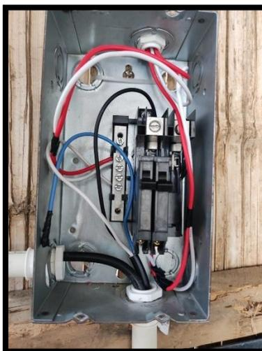
Imagen 30. Conexiones respectivas al panel de distribución.
