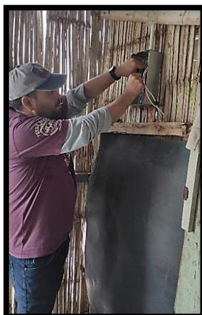
Imagen 29. Colocación del panel de distribución.
