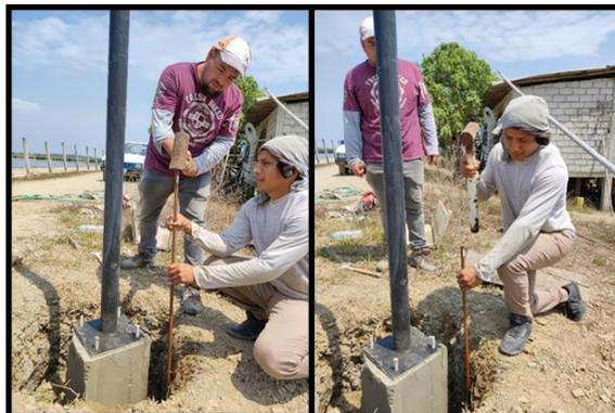
Imagen 26. Colocación de la varilla puesta a tierra.
