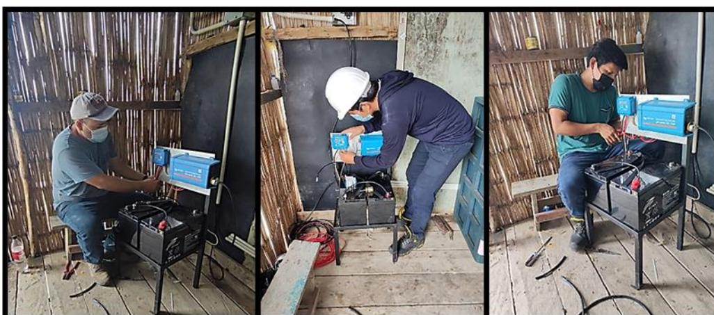
Imagen 33. Conexión de baterías, controlador e inversor
