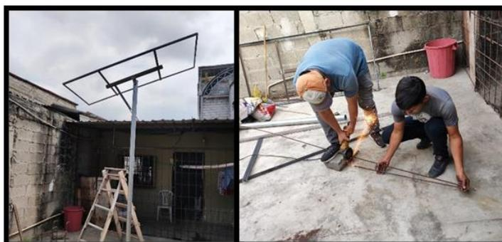
Imagen 24. Fabricación de la base del panel solar.
