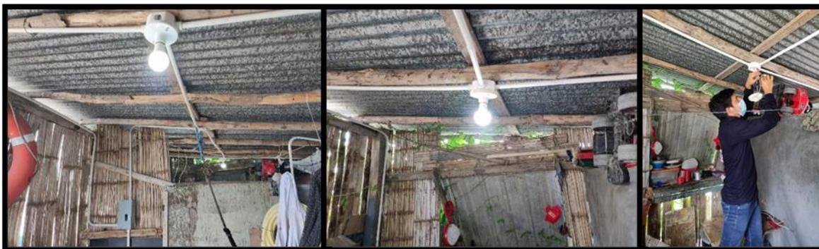
Imagen 31. Colocación y conexión de los puntos de iluminación.
