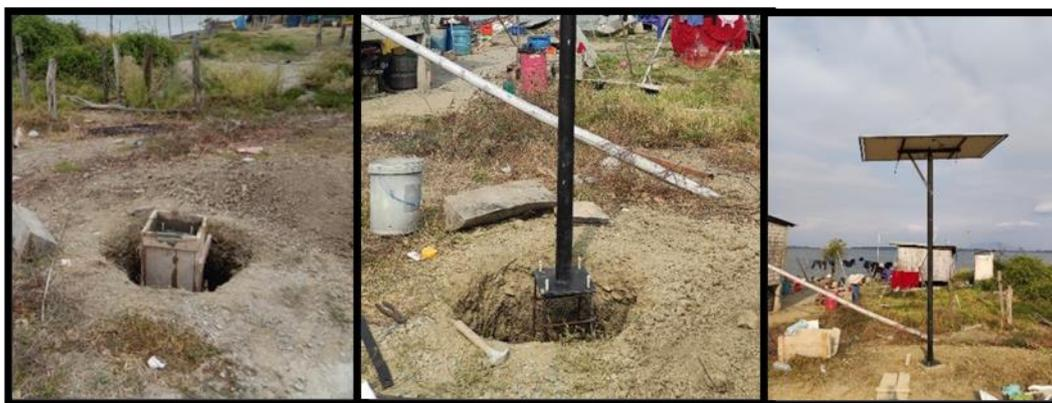
Imagen 25. Construcción de la base e instalación del panel solar.
