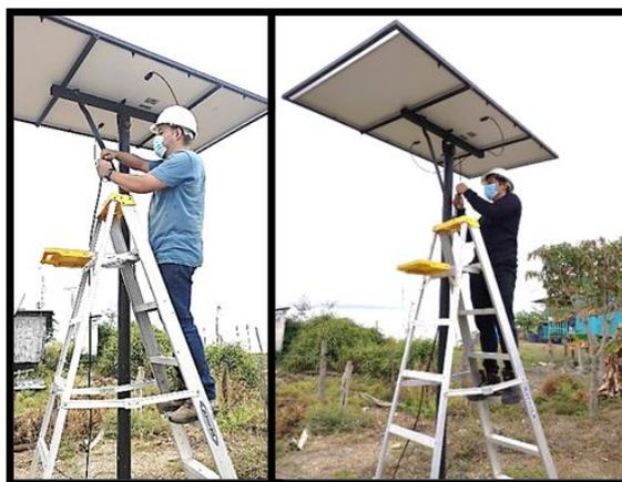
Imagen 27. Conexión del panel fotovoltaico
