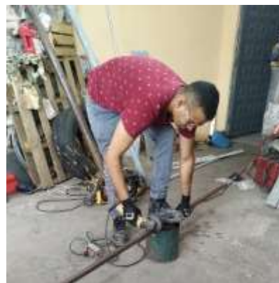
FIG. 62. CORTE DE TUBO CUADRADO PARA SOPORTE DEL KIT FOTOVOLTAICO (AUTOR)
