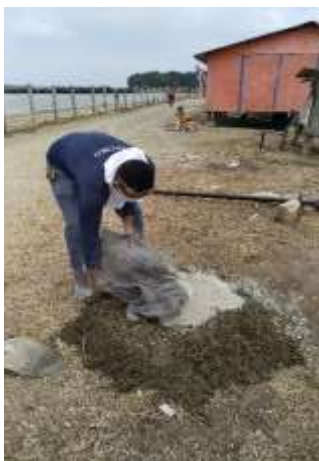
FIG. 68. PREPARACIÓN DE MEZCLA PARA LA BASE EXTERIOR (AUTOR)
