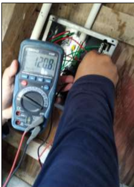
FIG. 73. COMPROBACIÓN DEL NIVEL DE TENSIÓN EN LA CAJA DE SERVICIO Y TOMACORRIENTES (AUTOR)
