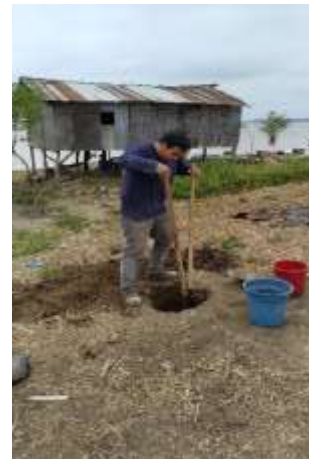
FIG. 67.1 EXCAVACIÓN PARA EL SOPORTE EXTERNO DEL SISTEMA FOTOVOLTAICO (AUTOR)
