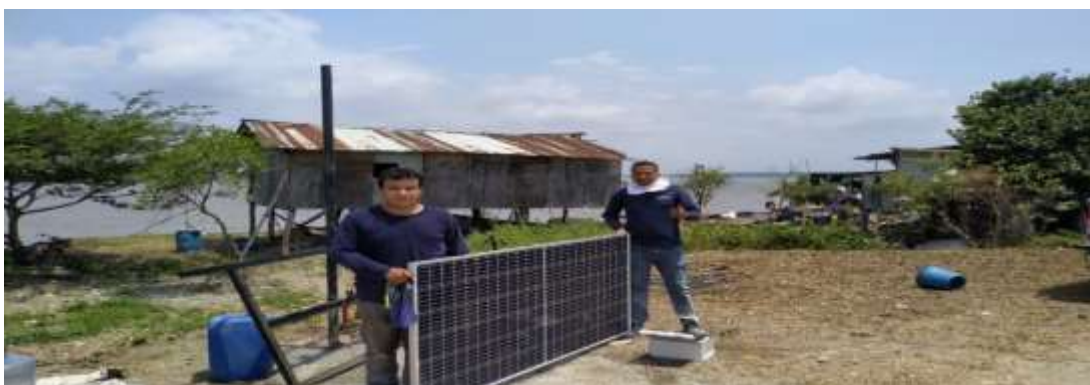
FIG. 70. AJUSTE DE LOS PERNOS PARA LA BASE DEL PANEL FOTOVOLTAICO (AUTOR)
