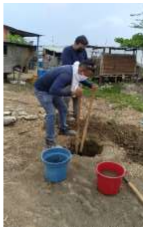
FIG. 67. EXCAVACIÓN PARA EL SOPORTE EXTERNO DEL SISTEMA FOTOVOLTAICO (AUTOR)
