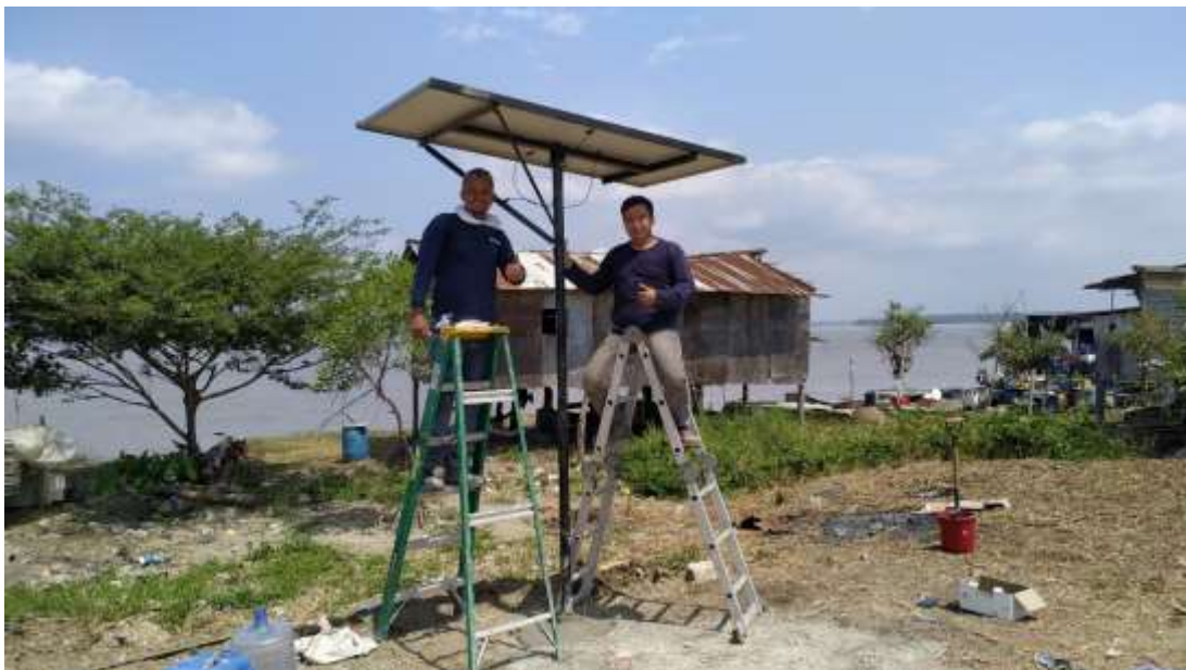
FIG. 71. MONTAJE Y AJUSTE DEL PANEL SOLAR AL SOPORTE EXTERIOR (AUTOR)
