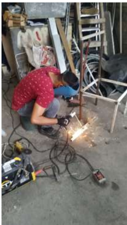
FIG. 63. SOLDADURA DEL SOPORTE INFERIOR DEL KIT FOTOVOLTAICO (AUTOR)
