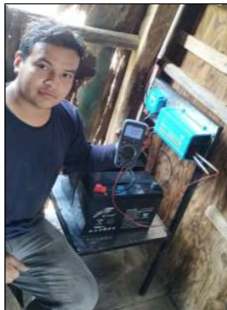
FIG. 72. COMPROBACIÓN DEL NIVEL DE TENSIÓN A LA SALIDA DEL INVERSOR (AUTOR)
