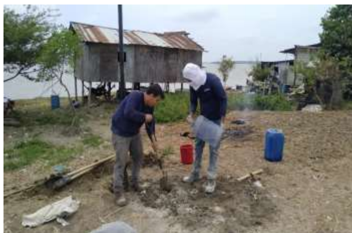
FIG. 69. LLENADO DE MEZCLA PARA LA BASE DEL SOPORTE EXTERIOR DEL SISTEMA (AUTOR)
